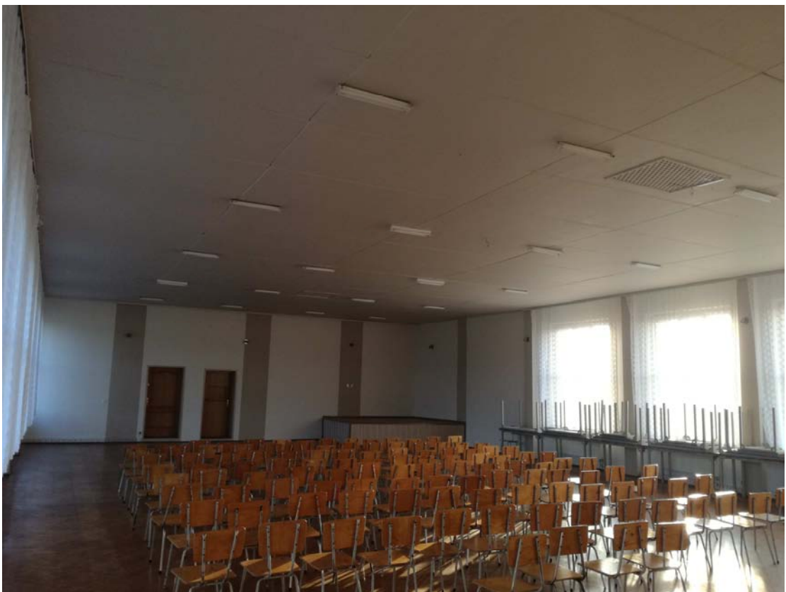
fot. nr 11 Widok sufitu podwieszanego do kratownic i krawędziaków pośrednich
