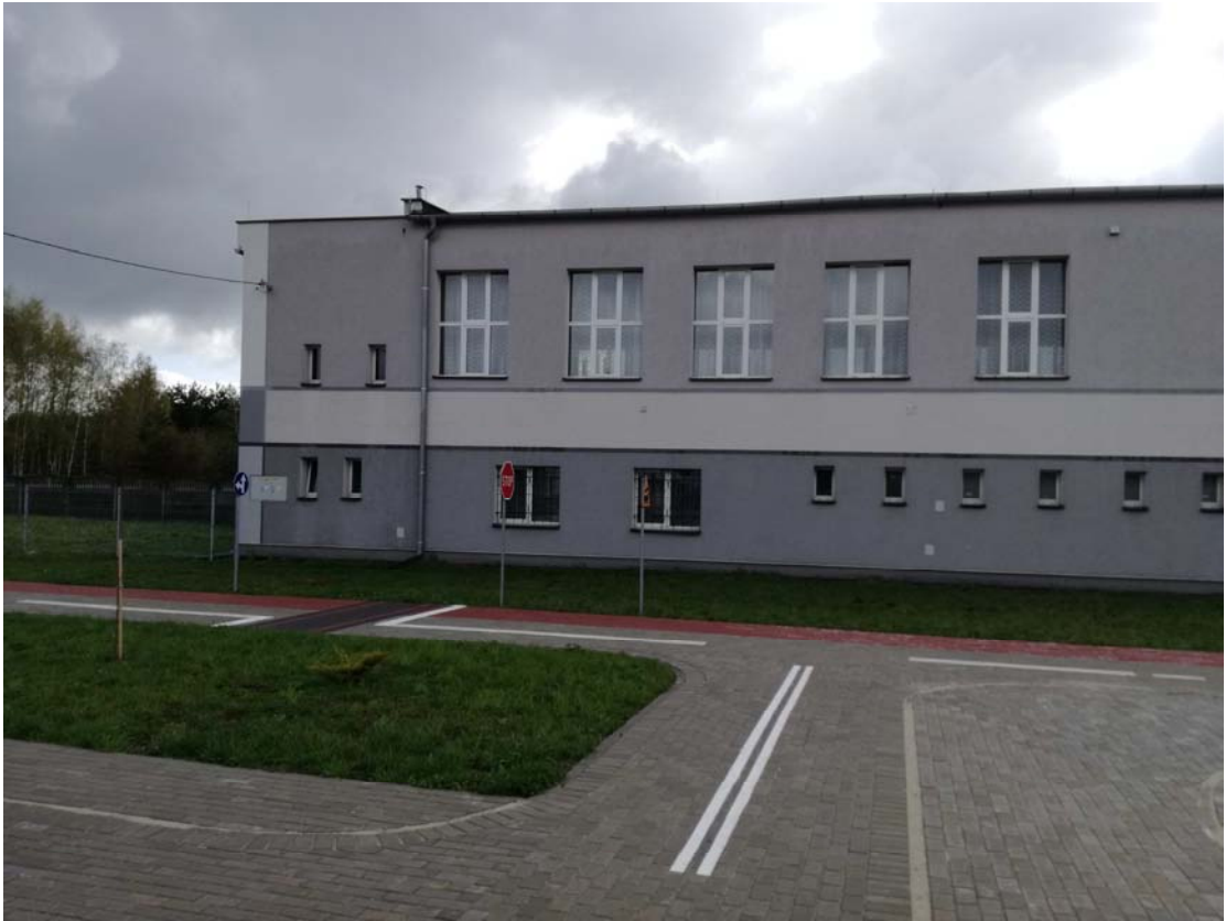
fot. nr 1 Widok budynku od strony zachodniej - część lewa
