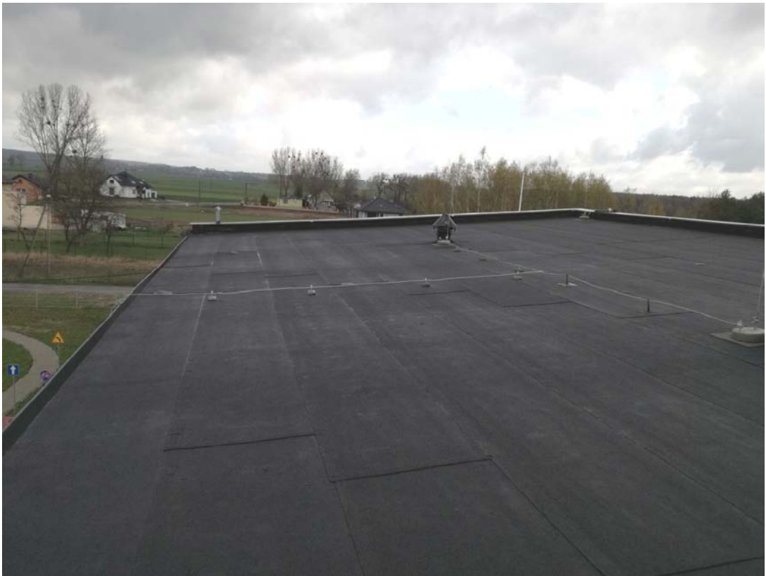
fot. nr 5 Widok połaci dachu objętej opracowaniem
