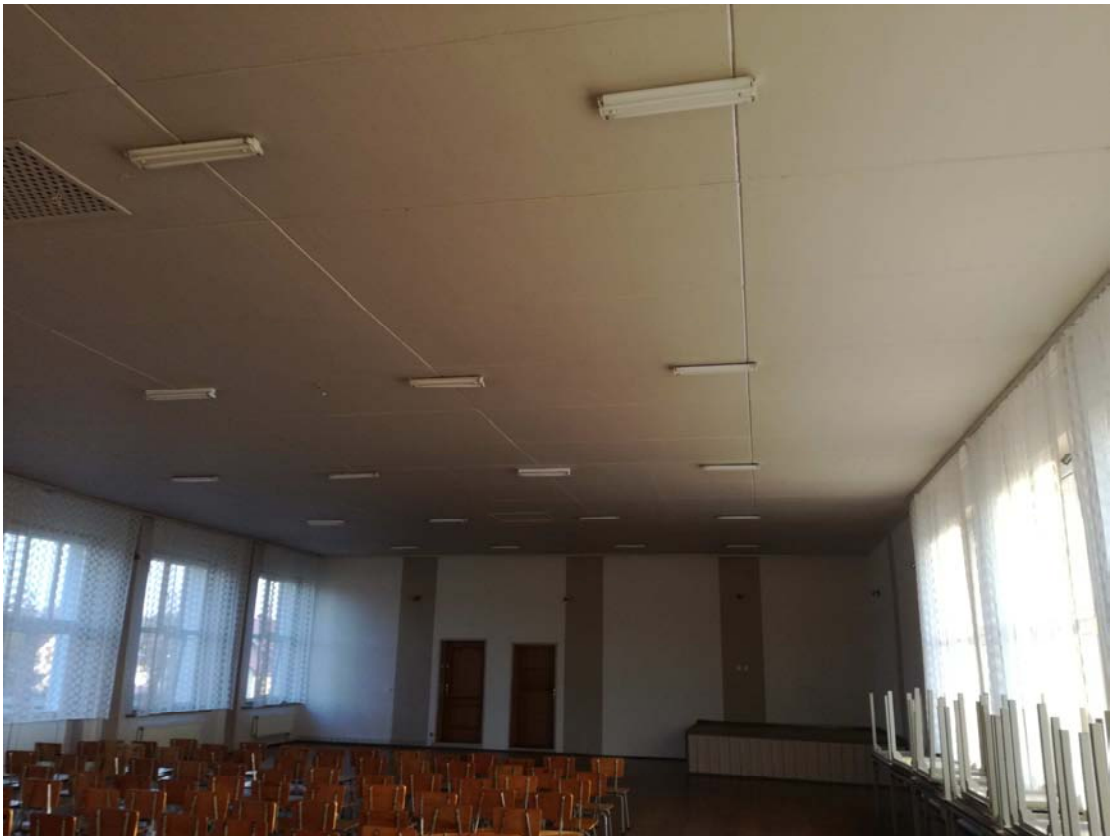
fot. nr 10 Widok sufitu podwieszanego do kratownic i krawędziaków pośrednich
