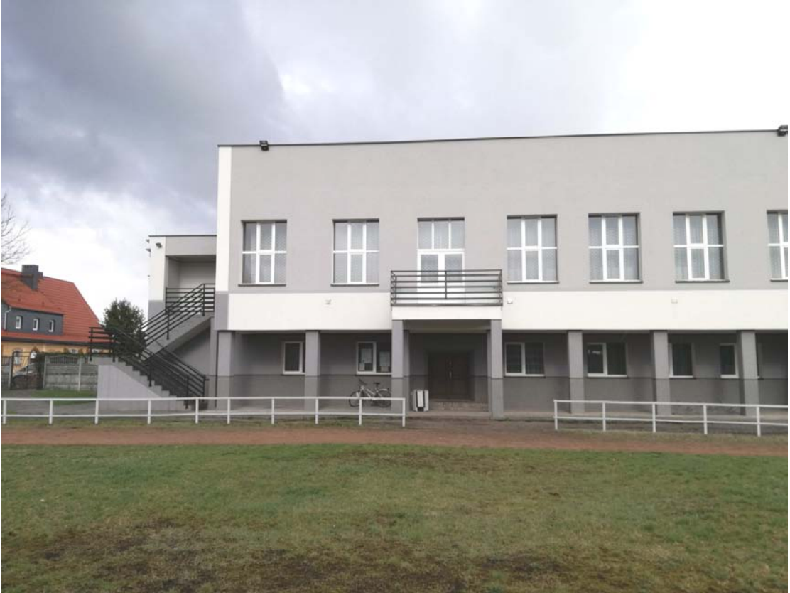
fot. nr 3 Widok budynku od strony wschodniej - część lewa
