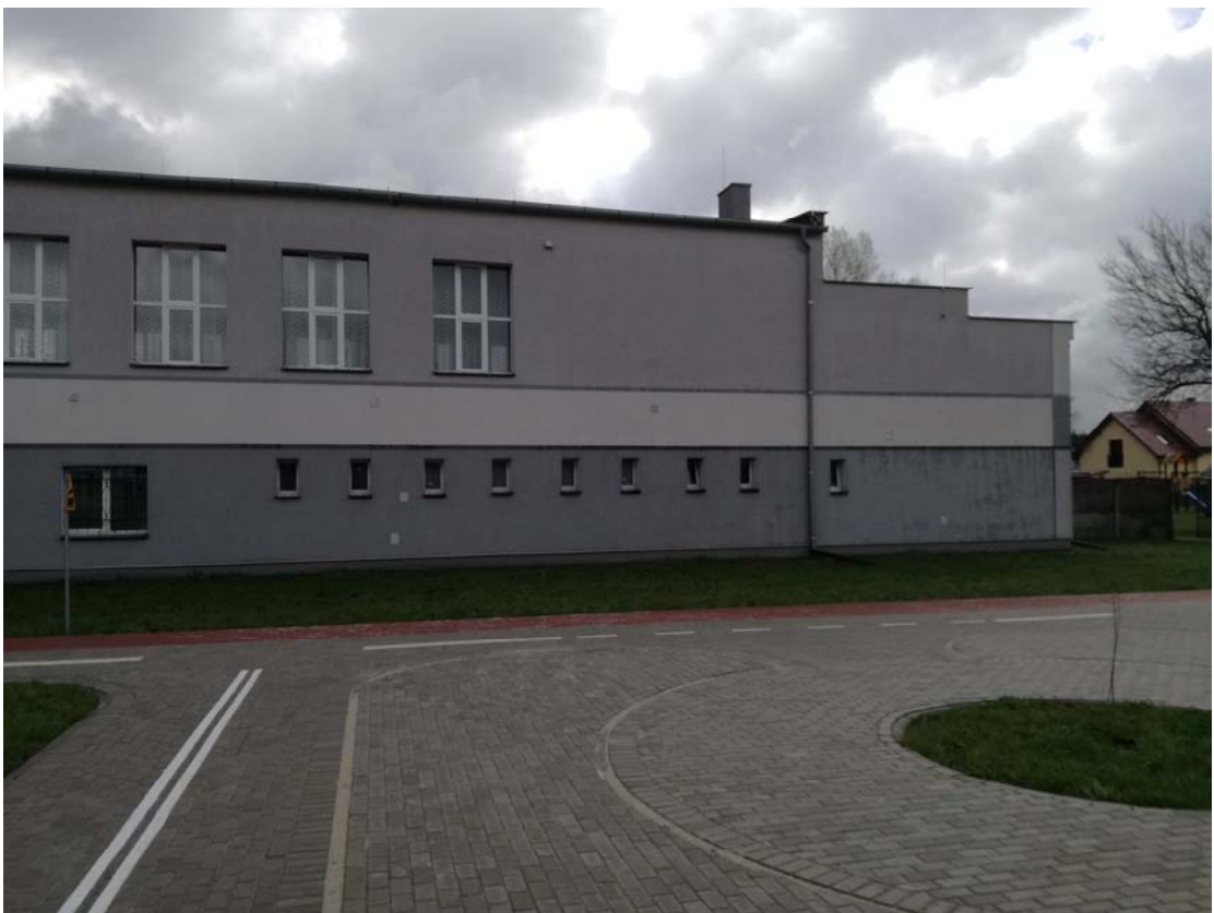
fot. nr 2 Widok budynku od strony zachodniej - część prawa
