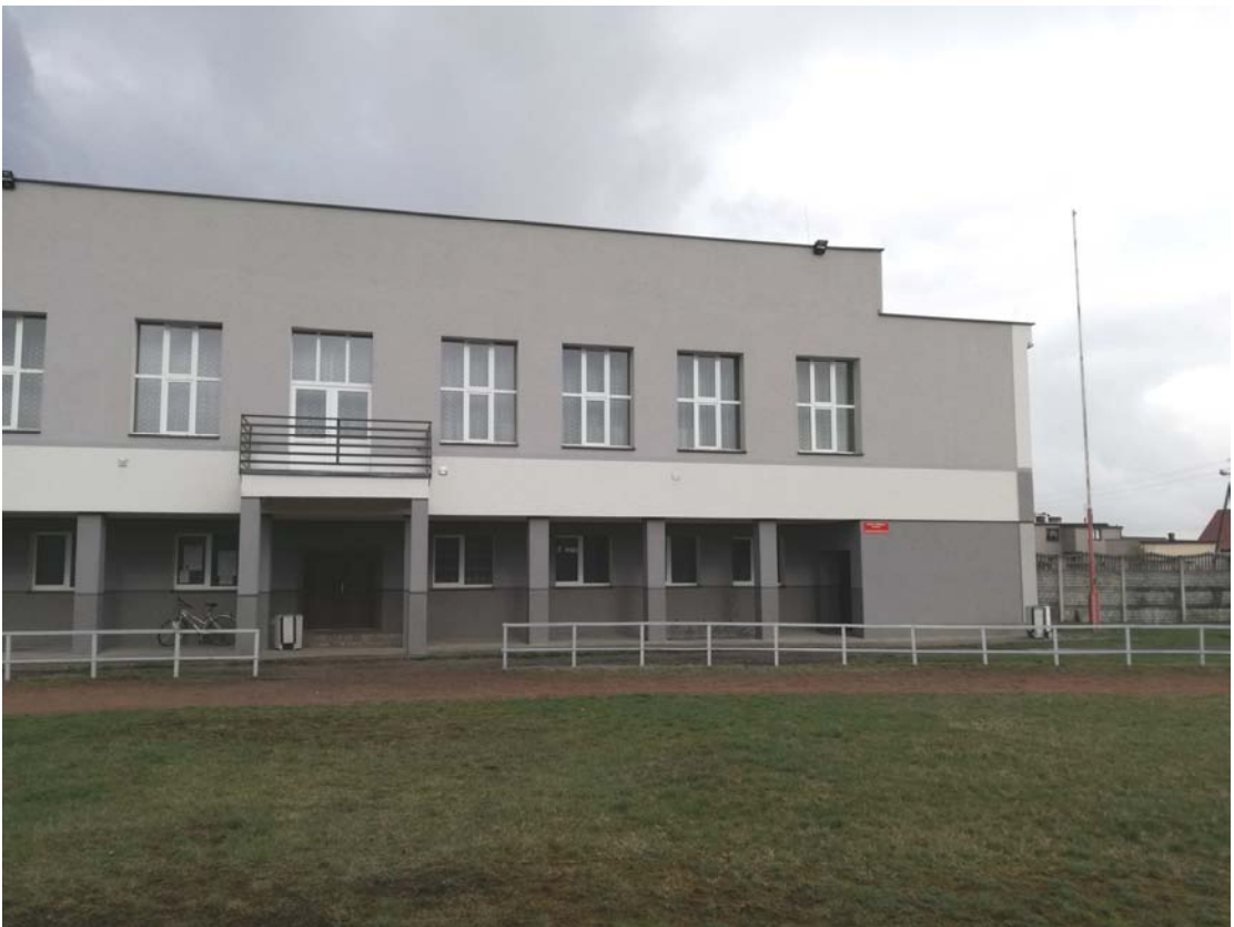
fot. nr 4 Widok budynku od strony wschodniej - część prawa
