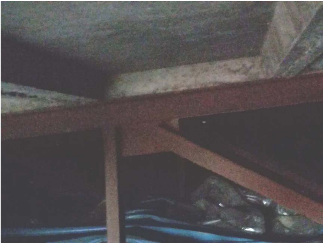
fot. nr 8 Widok węzła: pas górny/słupek/krzyżulec
