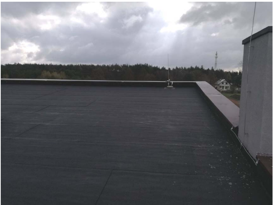
fot. nr 6 Widok połaci dachu objętej opracowaniem
