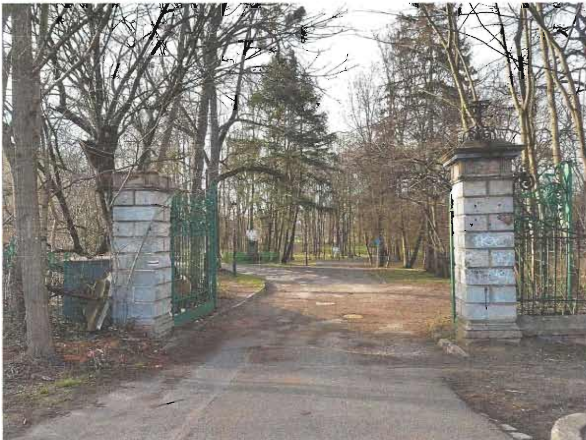
Zdjęcia uszkodzonej bramy do parku w Sławięcicach przy ul. W. Wróblewskiego
