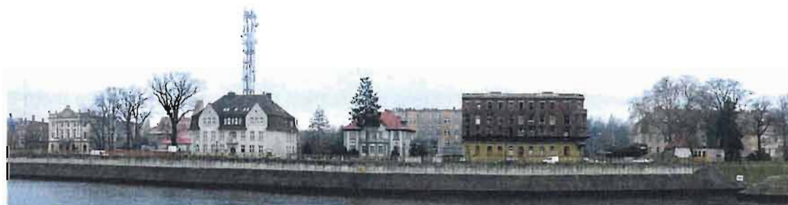
Rys. 3. Widok rejonu inwestycji od strony Odry, stan 2018r.
