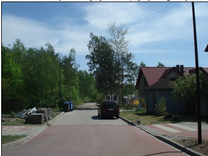
Fot. 10 Droga 4KDD, południowa część obszaru
