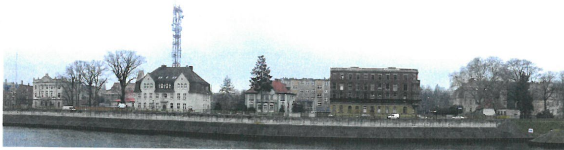
Rys. 3. Widok rejonu inwestycji od strony Odry, stan 2018r.
