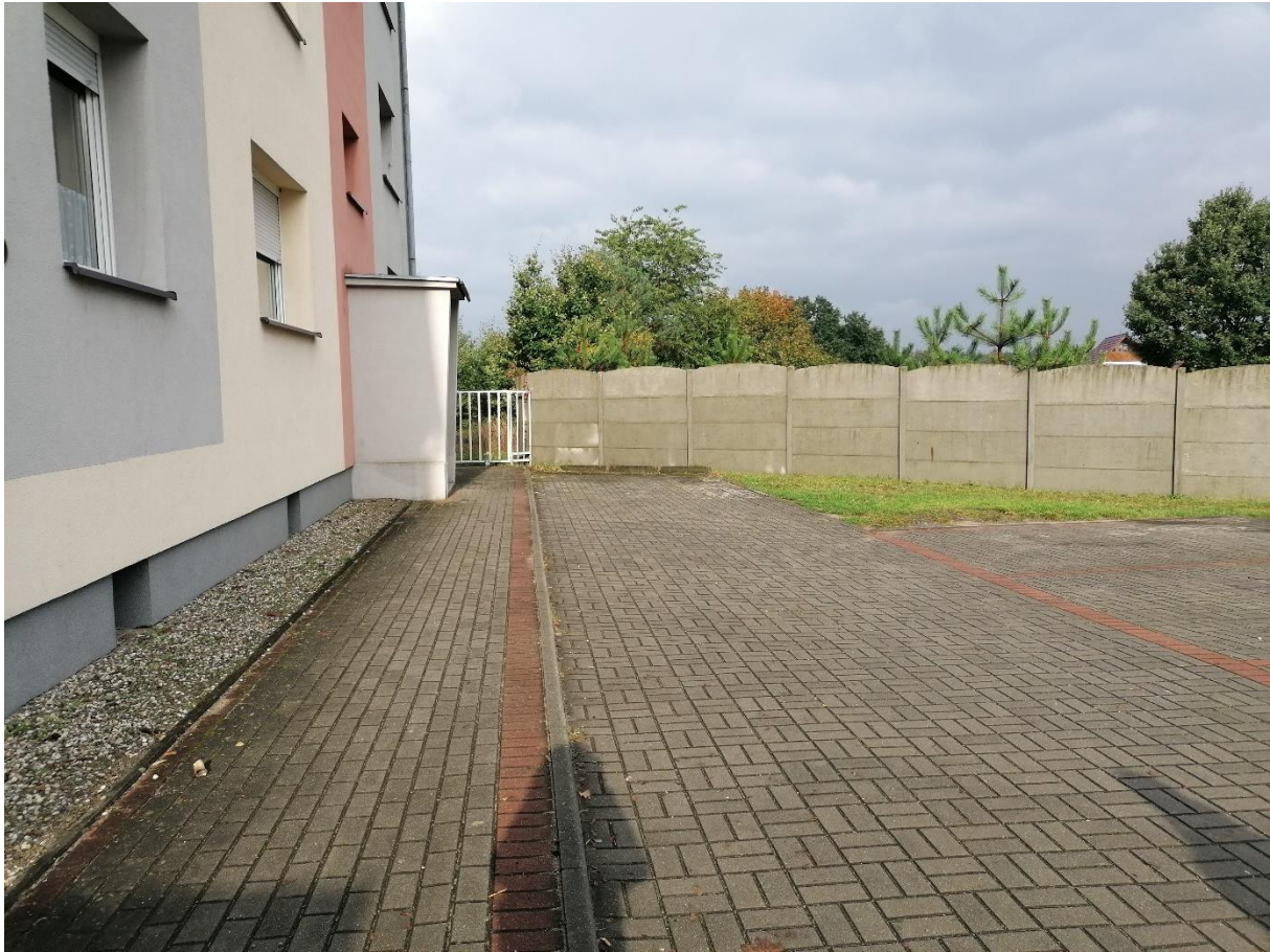
Foto 6. Widok na istniejący teren na wysokości budynku mieszkalnego numer 9 na działce numer 588/311 przy parkingu
