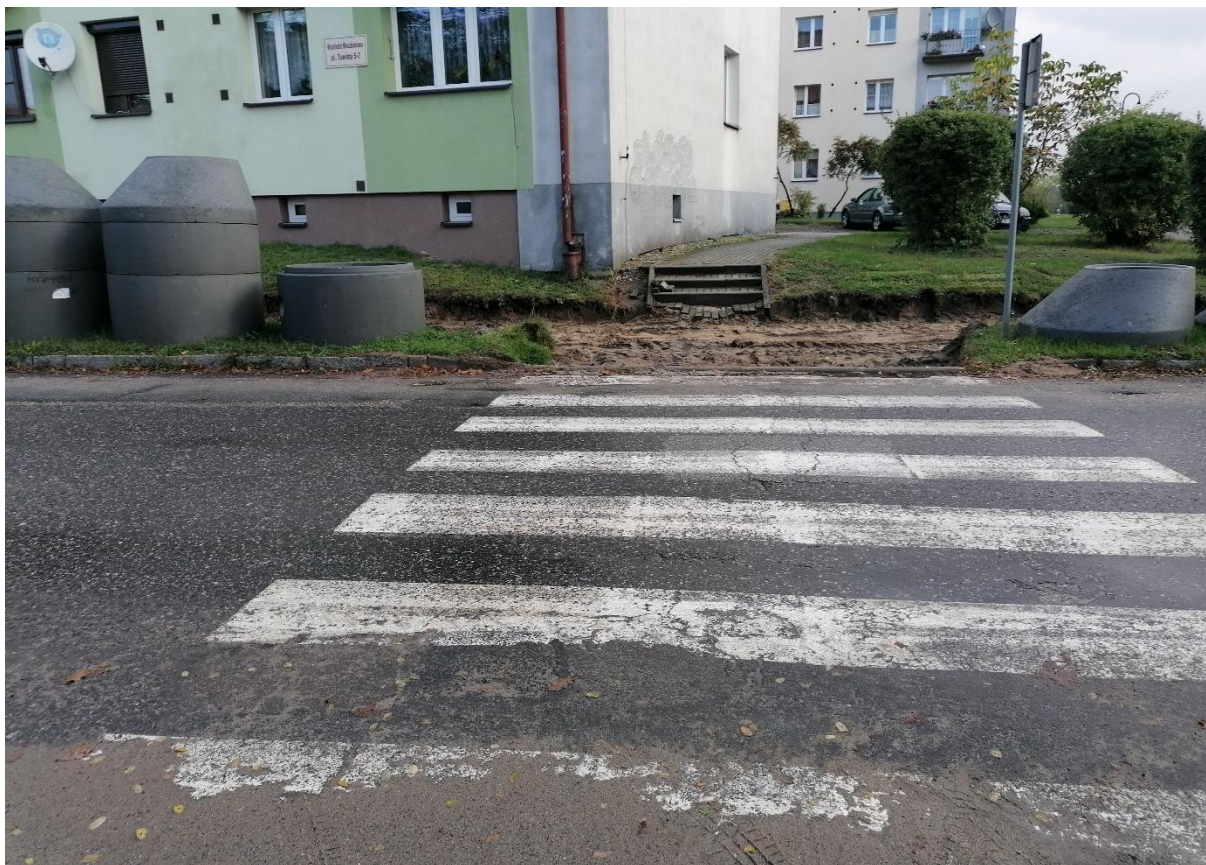
Foto 2. Widok na miejsce dowiązania się do przejścia dla pieszych
