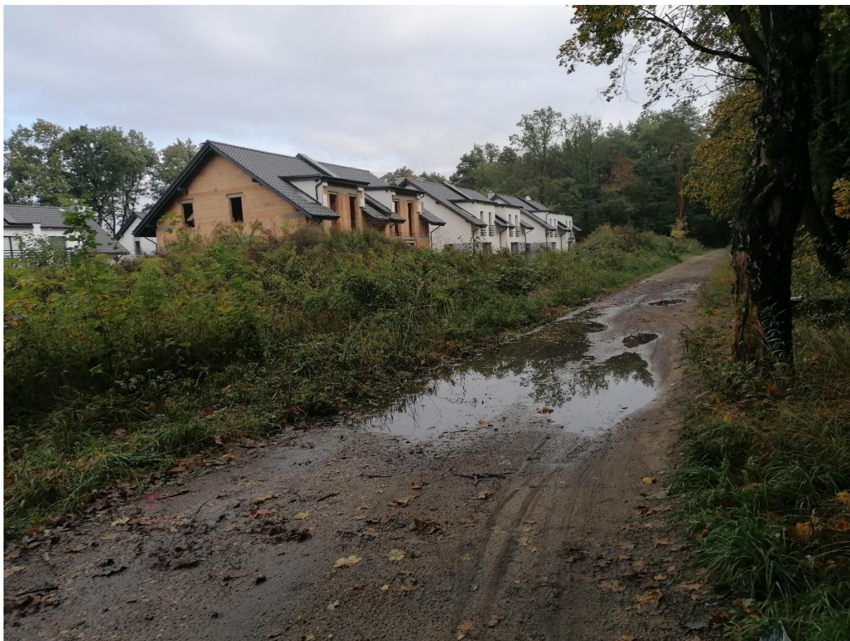
Foto 22. Widok na istniejący teren na wysokości działki 701/16
