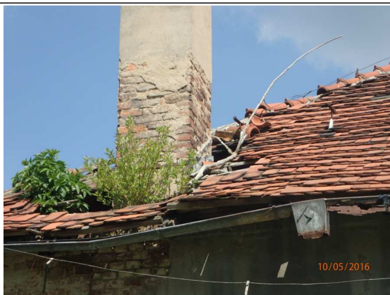
Fot. Z1-36. Zniszczony fragment połaci dachu i sys- temu odwodnienia dachu – widoczne znaczne porosty roślinne
