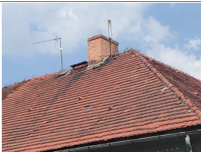
Fot. Z1-39. Stan połaci dachu w części mieszkalnej
