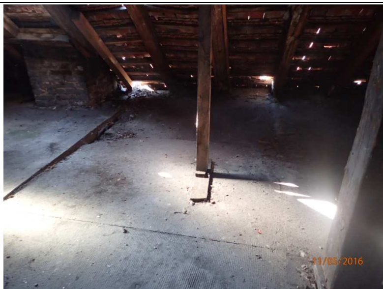
Fot. Z1-46. Prowizoryczne podparcie dodatkowym słupkiem krokwi, nieszczelności w poszyciu i załamana płyta posadzki w części „A”
