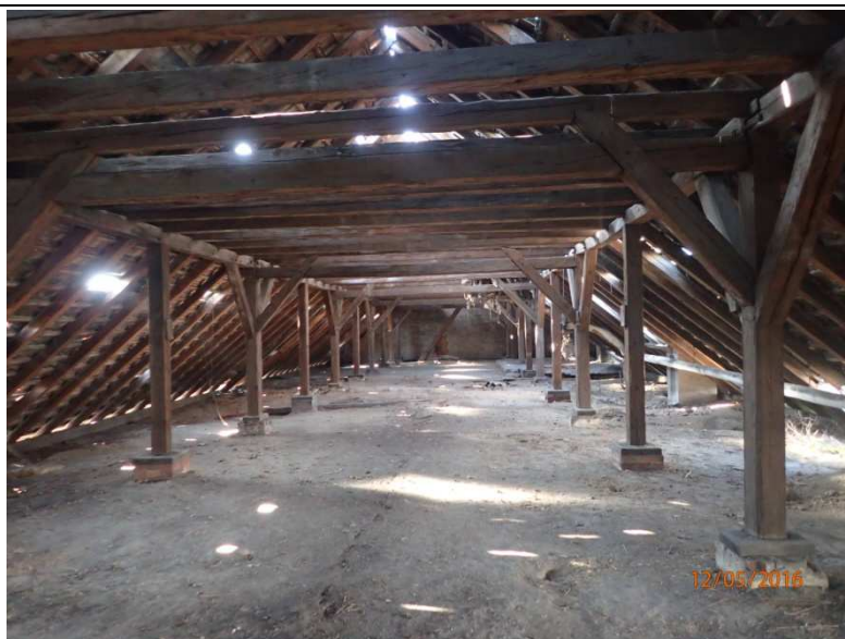
Fot. Z1-44. Układ konstrukcji drewnianej dachu nad częścią „B”
