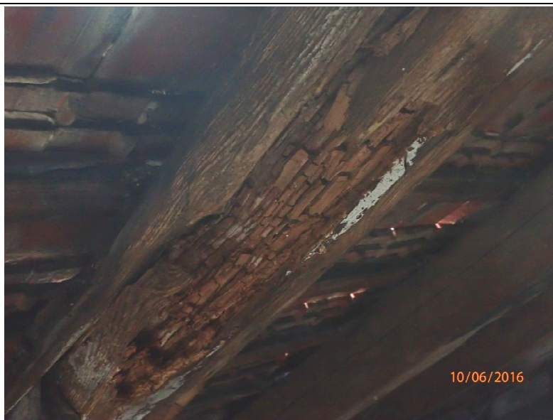
Fot. Z1-53. Zakres degradacji technicznej krokwi dachowej w części „A”
