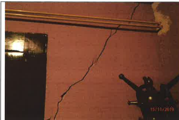
Fot. 16. Pęknięcie przelotowe wewnętrznej ściany
