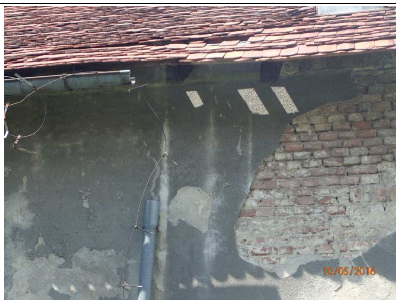
Fot. Z1-28. Zdewastowany system odwodnienia dachu – braki odcinków rynien i rury spustowej
