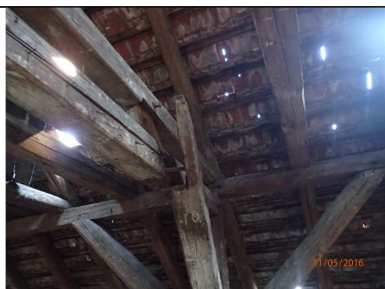
Fot. 21. Rozszczepienia węzła więźby
