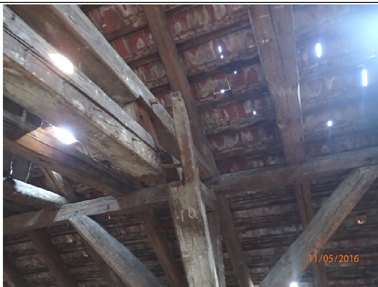
Fot. Z1-50. Rozpięty układ węzłowy więźby dachowej w części „A”
