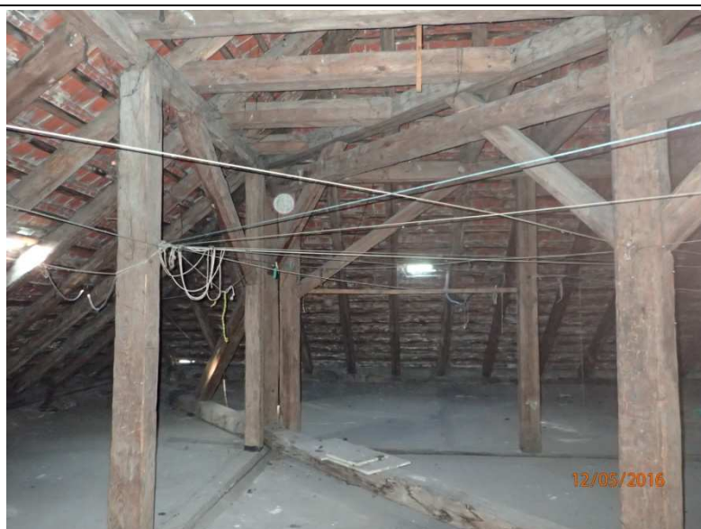
Fot. Z1-45. Układ konstrukcji drewnianej dachu nad częścią mieszkalną „M”
