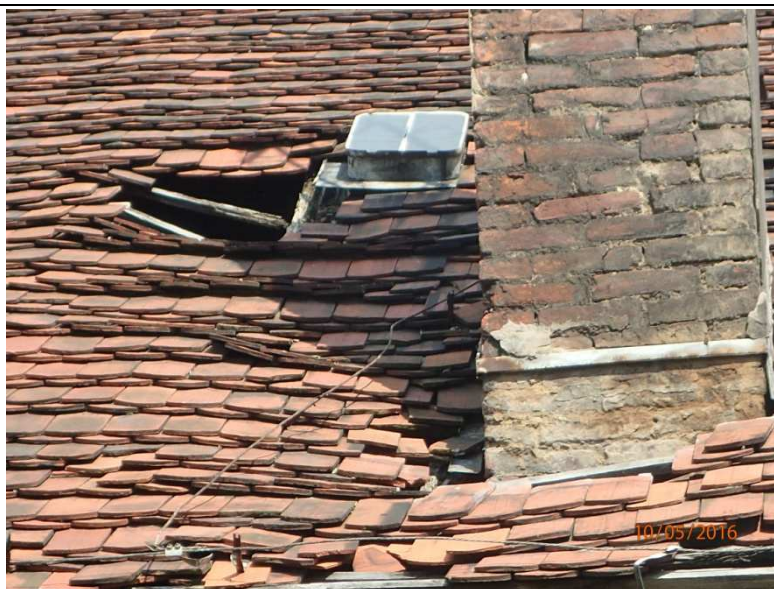
Fot. Z1-38. Degradacja połaci dachu w rejonie lokalizacji komina
