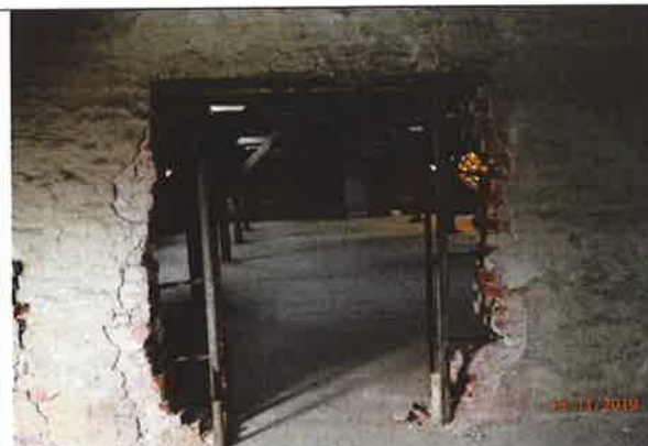
Fot. 25. Przejęcie w ścianie ogniowej
