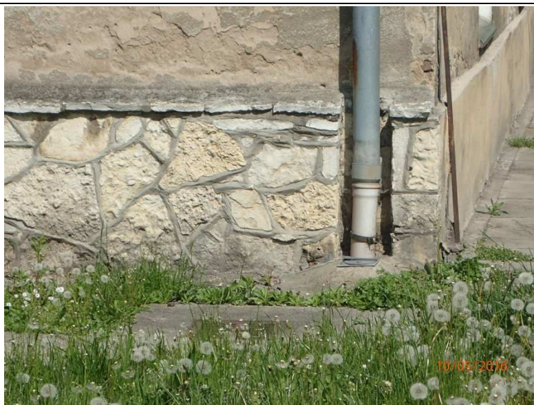
Fot. Z1-20. Cokół i odprowadzenie wód opadowych w części mieszkalnej „M”
