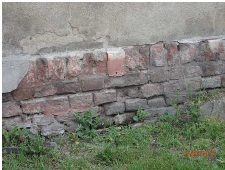
Fot. 12. Obraz stanu technicznego partii cokołowych murów
