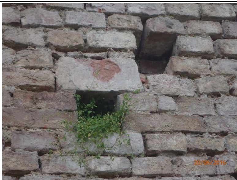
Fot. Z1-14. Porosty roślinne i luźne cegły w murze zewnętrznym elewacji zachodniej
