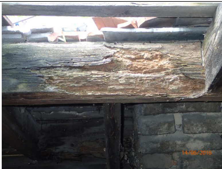
Fot. Z1-62. Widoczne ślady i zakres porażenia owa- dami wymianu przy kominie
