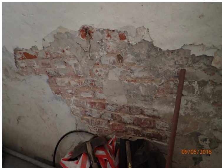
Fot. 14. Degradacja powierzchni sklepienia wskutek zamakania
