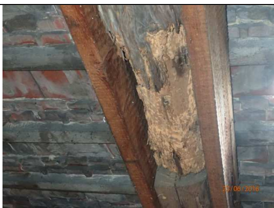
Fot. 16. Porażenie krokwi owadami
