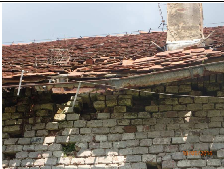
Fot. Z1-24. Zniszczenia fragmentu połaci dachu, korony murów i rynien w części „B” od strony zachodniej
