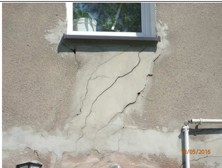
Fot. Z1-16. Pęknięcia ściany i nieskuteczność naprawy na elewacji zachodniej części mieszkalnej „M”
