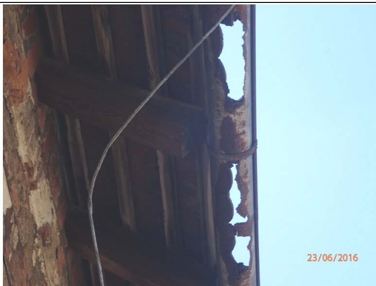
Fot. Z1-32. Skorodowane rynny i luźne przewody instalacji odgromowej w części „A”
