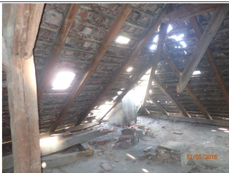
Fot. Z1-60. Zniszczenia dachu w partii szczytowej części „B”
