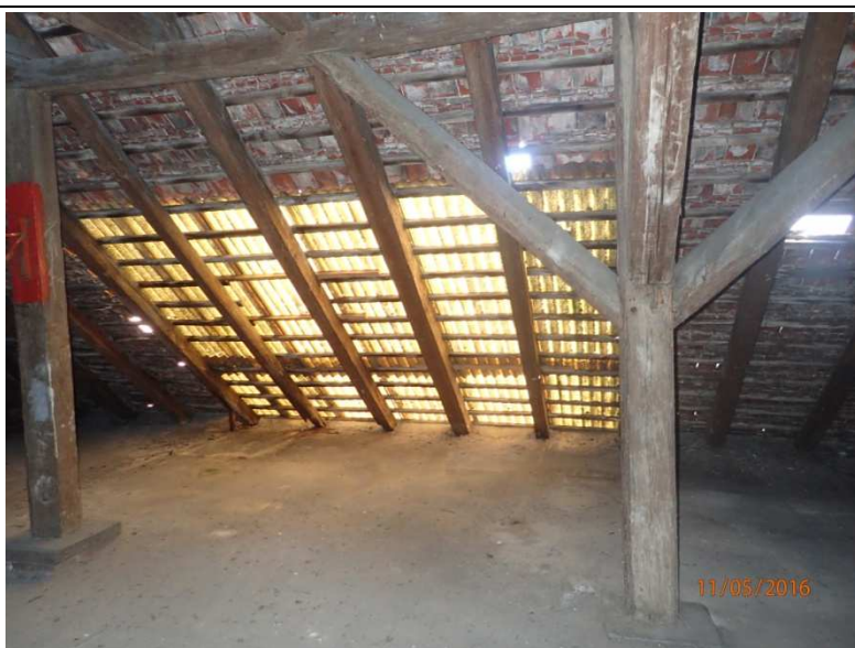
Fot. Z1-48. Zastępcze uszczelnienie dachu za pomo- cą płyt falistych
