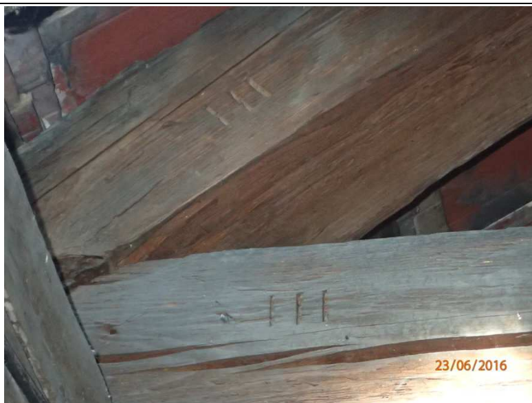
Fot. Z1-65. Widoczne ciesielski znaki montażowe na jętce i krokwi
