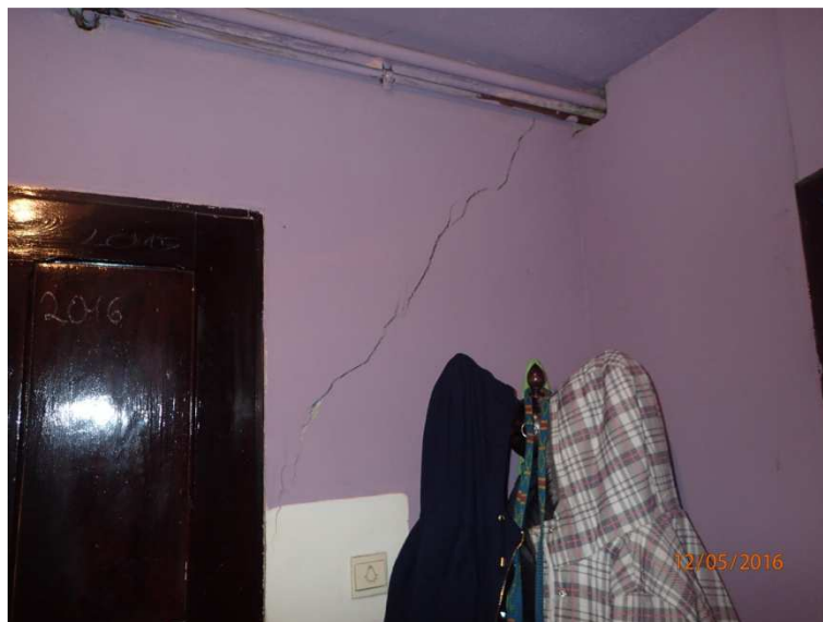
Fot. 13. Pęknięcie ściany w części mieszkalnej
