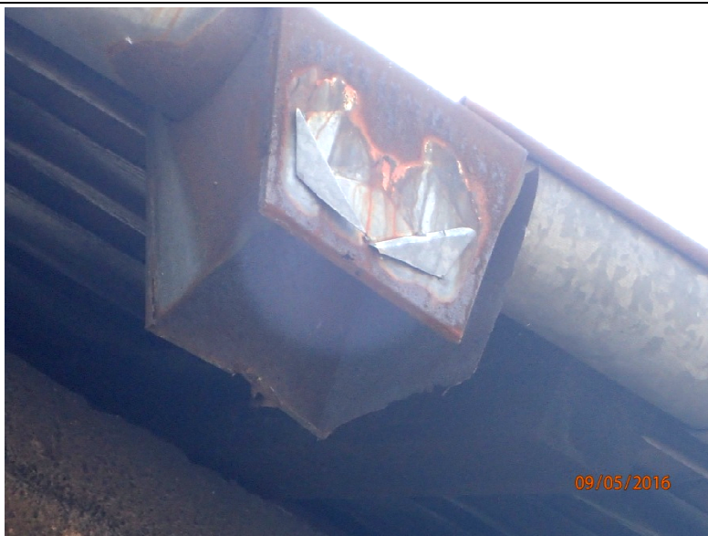
Fot. Z1-27. Zniszczony kosz rynnowy z brakiem połączenia z rurą spustową
