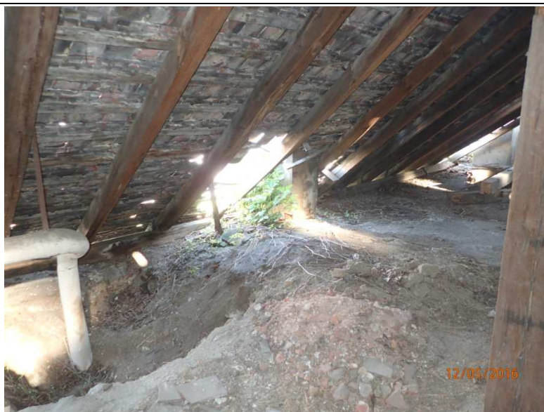
Fot. Z1-59. Zakres znacznych obszarów zniszczeń dachu w części „B”
