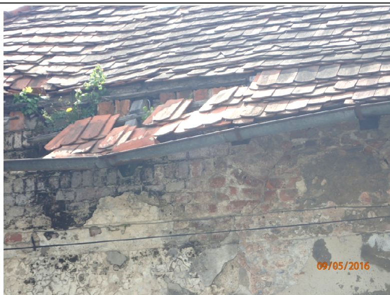
Fot. Z1-33. Załamanie połaci dachu i zniszczone rynny od strony północnej części „B”
