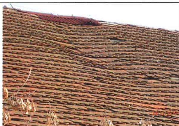
Fot. 6. Załamanie połaci dachu
