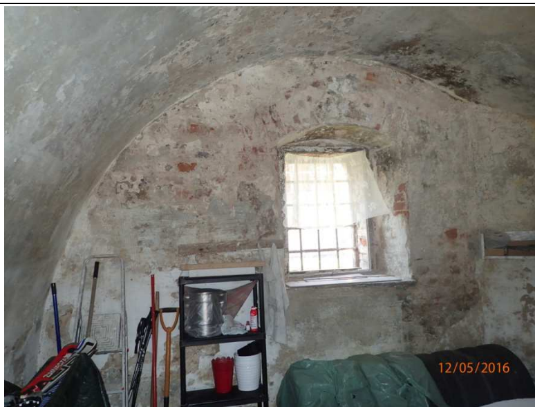
Fot. Z1-71. Znaczne ślady zawilgoceń ściany i skle- pienia kazamaty w części „A”
