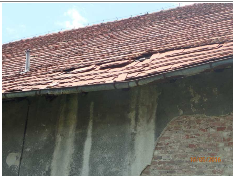
Fot. Z1-30. Załamanie połaci dachu i zniszczone przez korozję rynny
