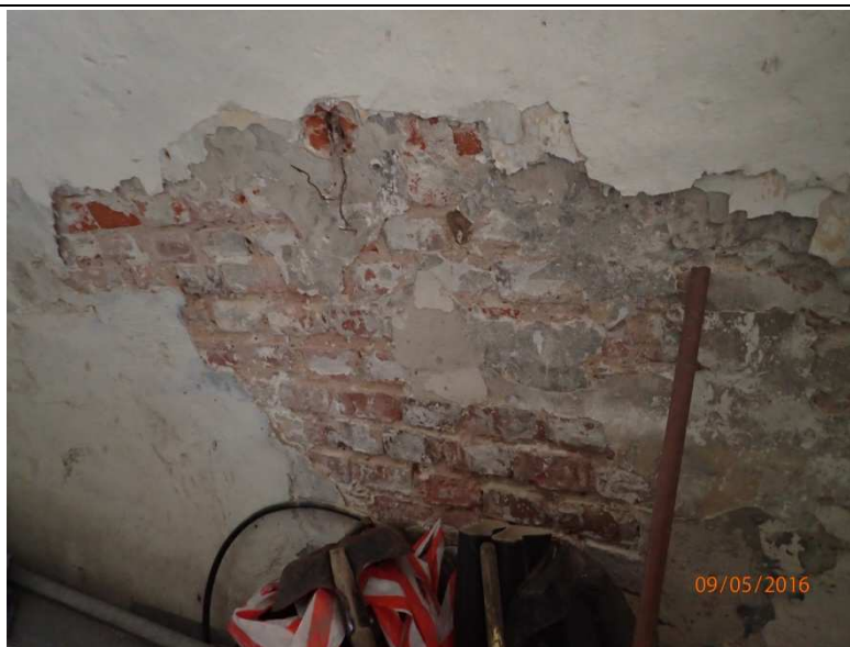
Fot. Z1-68. Widoczne ślady i konsekwencje zawil- gocenia sklepienia w kazamacie B1
