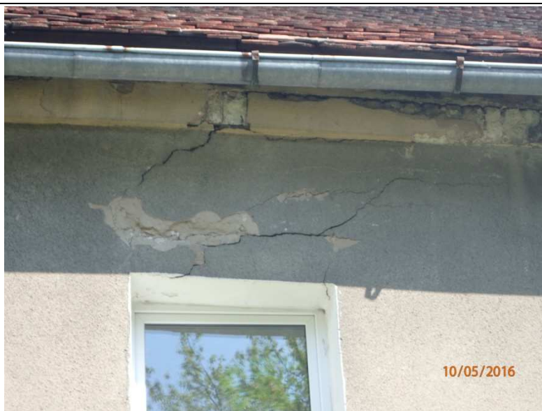
Fot. Z1-26. Pęknięcia i zarysowani korony murów w części mieszkalnej „M”
