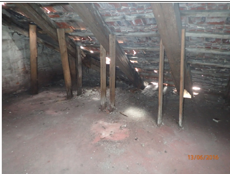
Fot. Z1-47. Prowizoryczne podparcia szeregu krokwi w części „A”
