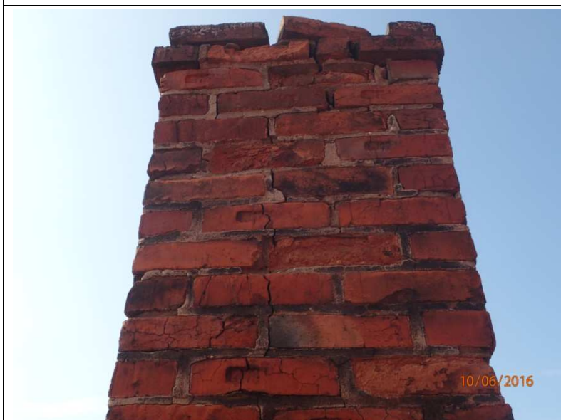
Fot. Z1-42. Stan komina w górnej jego partii - widoczne spękania i erozja powierzch- niowa cegieł
