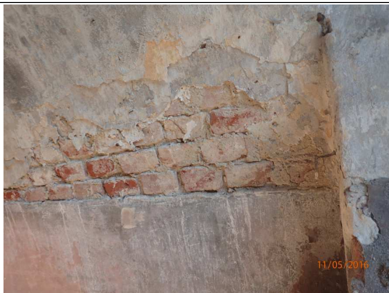
Fot. Z1-70. Widoczne ślady po zawilgoceniach na sklepieniu kazamaty B3
