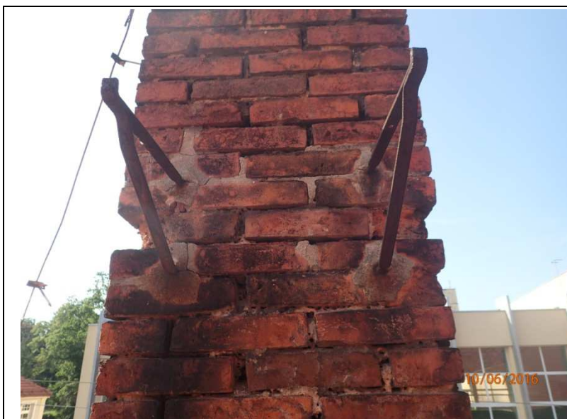
Fot. Z1-40. Stan techniczny komina murowanego – widoczna erozja zaprawy wiążącej oraz brak ławy kominiarskiej
