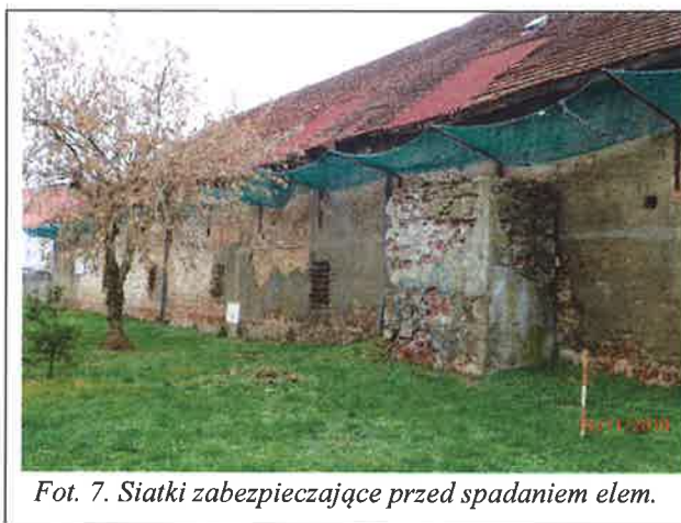
Fot. 8. Siatki zabezpieczające przed spadaniem elem.
