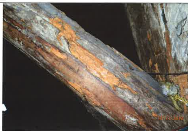
Fot. 10. Porażenie owadami elementów więźby
