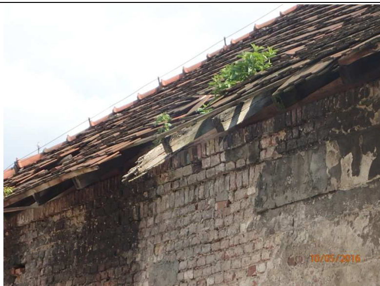
Fot. Z1-25. Degradacja połaci dachu i korony murów od strony północnej w części „B”
