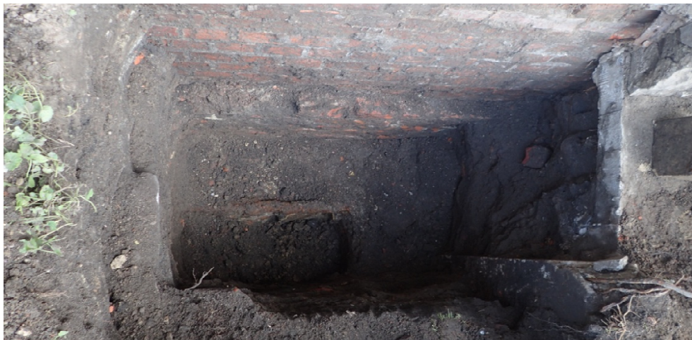
Fot. 10. Stan murów fundamentowych w odkrywce OF-2
