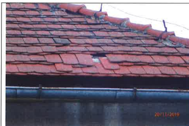
Fot. 3. Ubytki dachówek w części mieszkalnej
