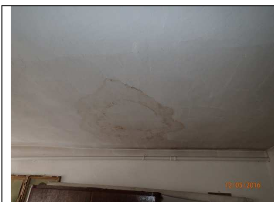
Fot. 22. Zaciek sufitowy na I piętrze
