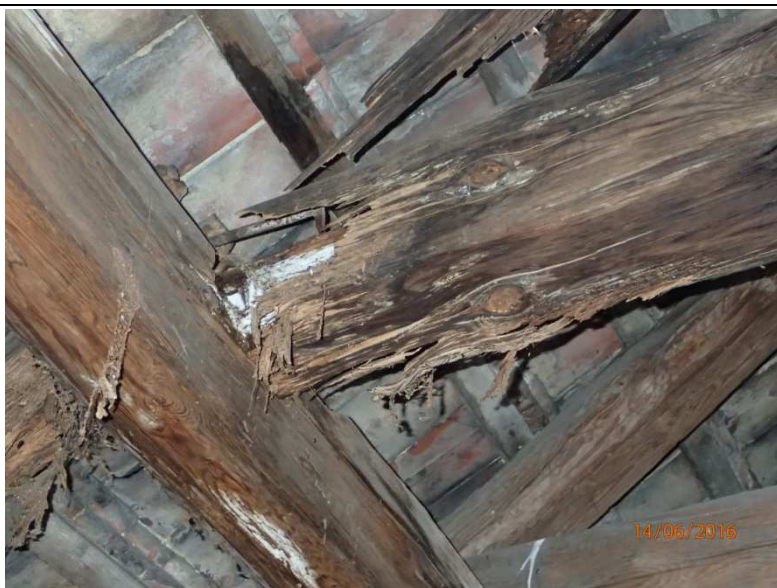
Fot. Z1-61. Zbutwiałe podparcie jętki i krokwi w części „B”
