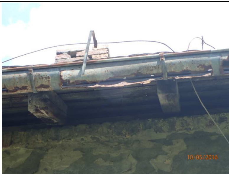
Fot. Z1-29. Skorodowane rynny i luźne przewody instalacji odgromowej
