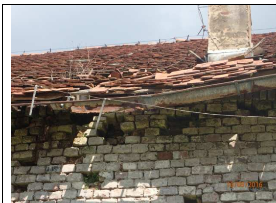
Fot. 26. Skorodowane rynny i stan korony
