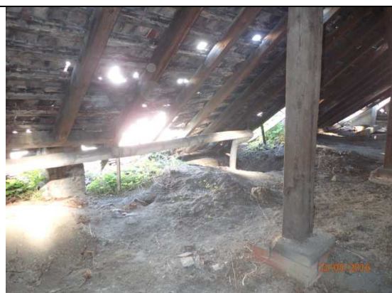
Fot. 25. Nieszczelności dachu w części „B”
