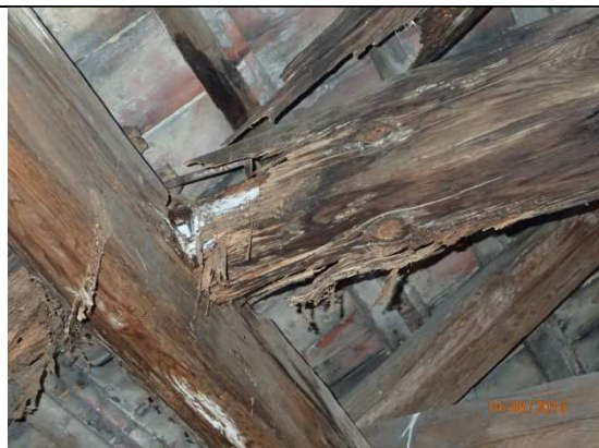
Fot. 19. Ślady degradacji biologicznej
