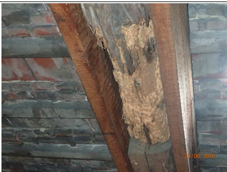
Fot. Z1-63. Zakres porażenia krokwi owadami oraz sposób jej wzmocnienia
