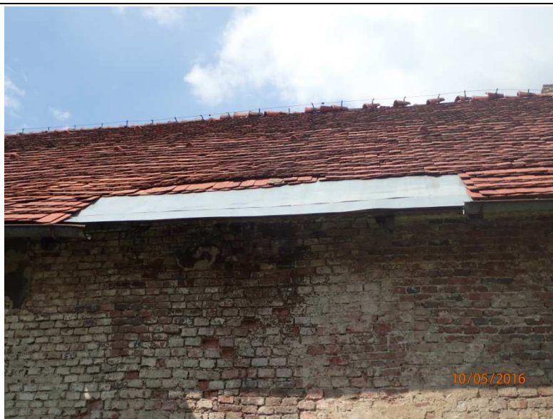
Fot. Z1-35. Prowizoryczna naprawa poszycia dachu za pomocą blachy ocynkowanej i leżące w kalenicy luźne gąsiory
