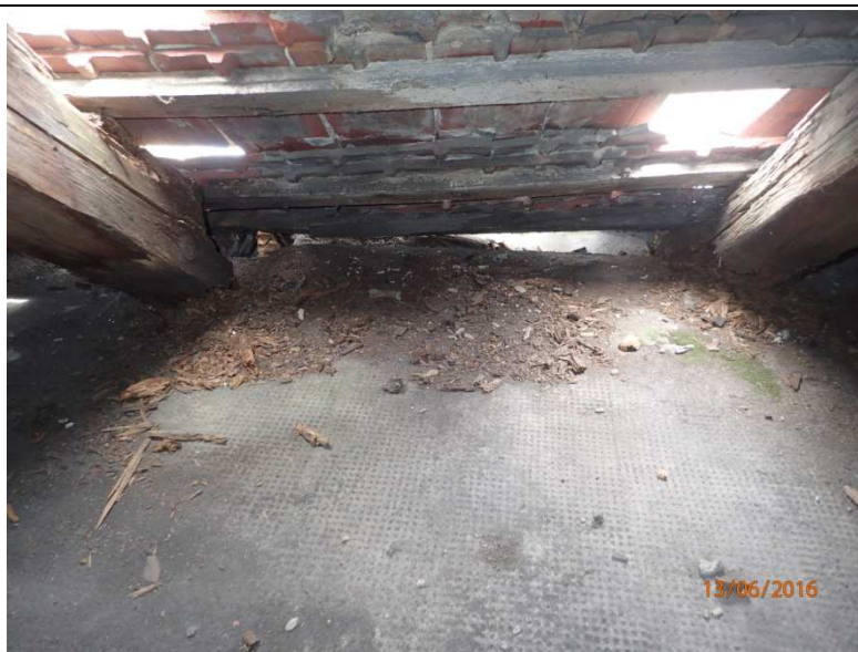
Fot. Z1-56. Zakres zniszczeń w rejonie oparcie krokwi na namurnicy w części „A”
