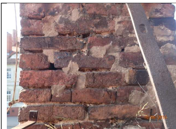
Fot. 28. Stan zaprawy i powierzchni komina
