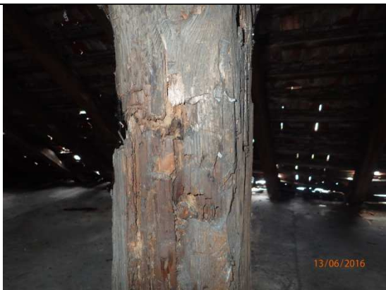
Fot. 18. Zniszczenia mechaniczne słupa
