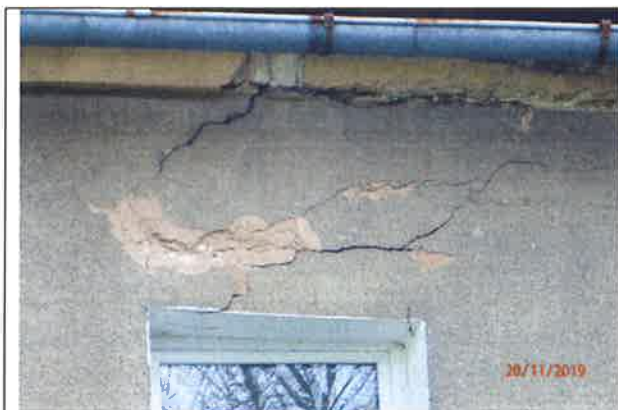
Fot. 18. Pęknięcia w górnej partii nadokiennej
