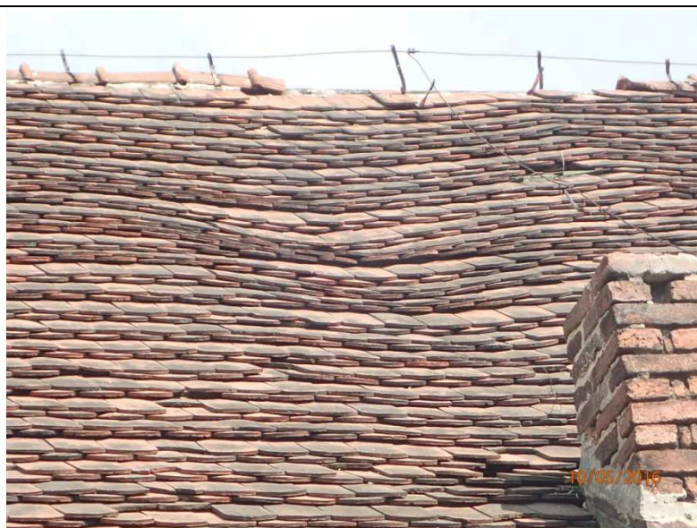
Fot. Z1-37. Widoczne falowanie połaci dachu i braki gąsiorów w kalenicy
