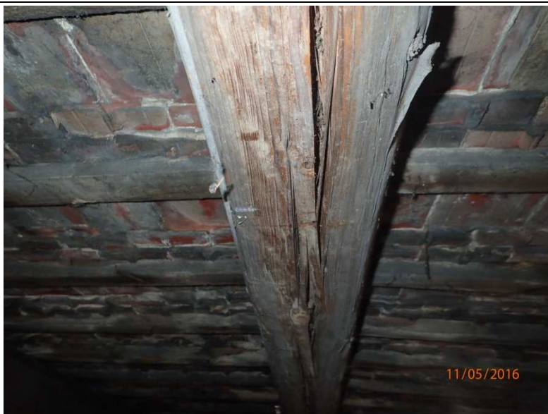
Fot. Z1-54. Rozszczepienie i rozwarstwienie po- dłużne krokwi w części „A”
