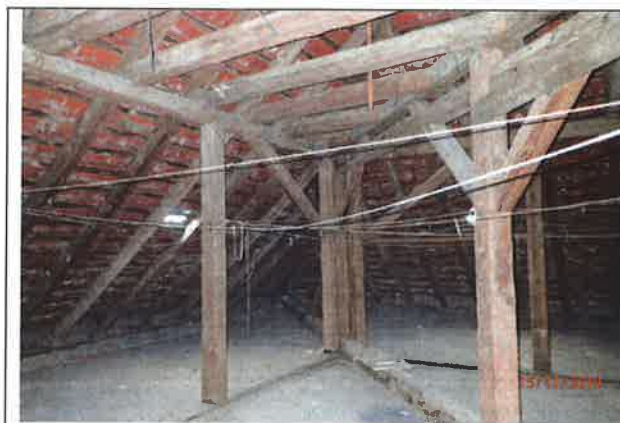
Fot. 9. Układ więźby nad częścią mieszkalną
