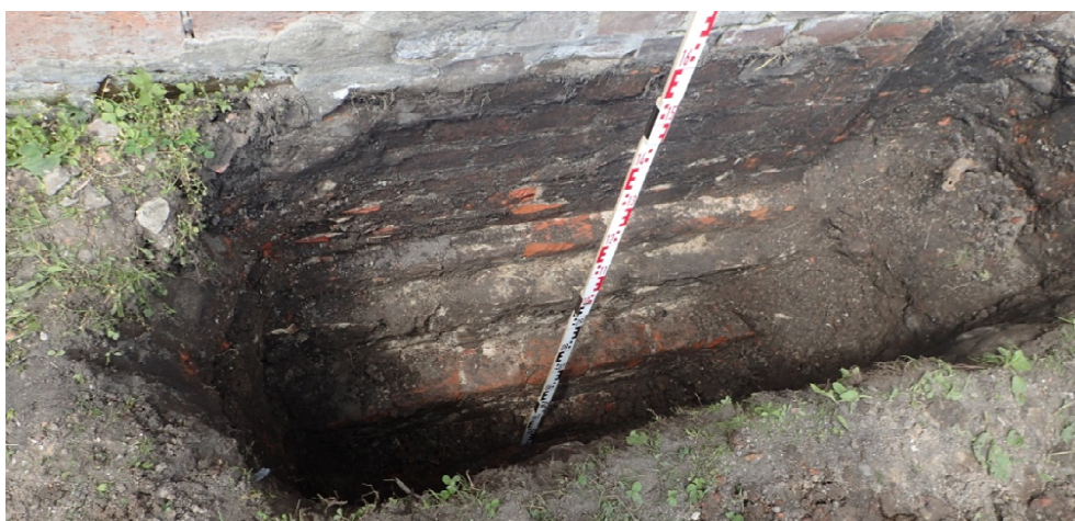
Fot. 9. Stan murów fundamentowych w odkrywcę OF-1
