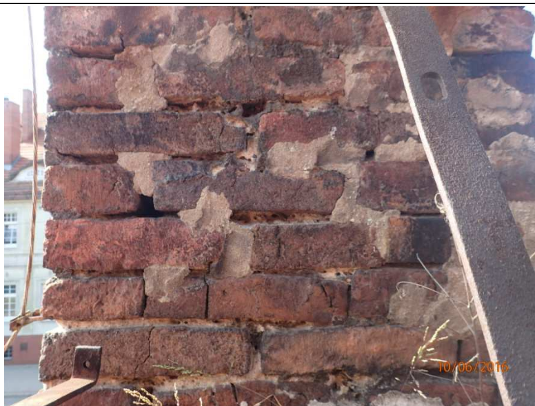
Fot. Z1-41. Obrazowy stan komina z widocznymi ubytkami zaprawy oraz erozją cegieł
