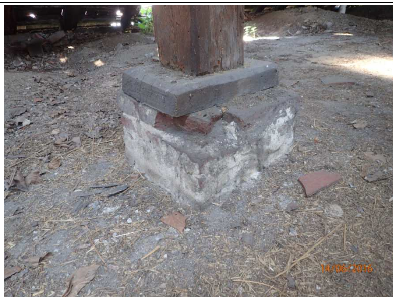
Fot. Z1-64. Podstawa słupa więźby dachowej w części „B”
