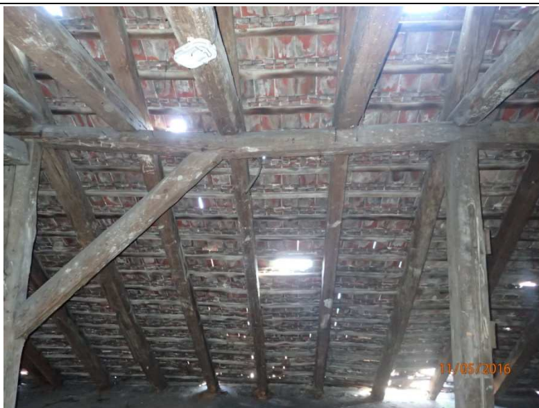
Fot. Z1-52. Widoczne znaczne ugięcie płatwi w układzie podłużnym części „A”
