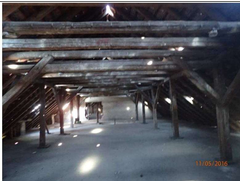
Fot. Z1-43. Układ konstrukcji drewnianej dachu nad częścią „A”
