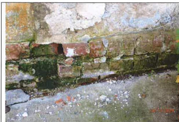
Fot. 20. Degradacja biologiczna cokołu budynku
