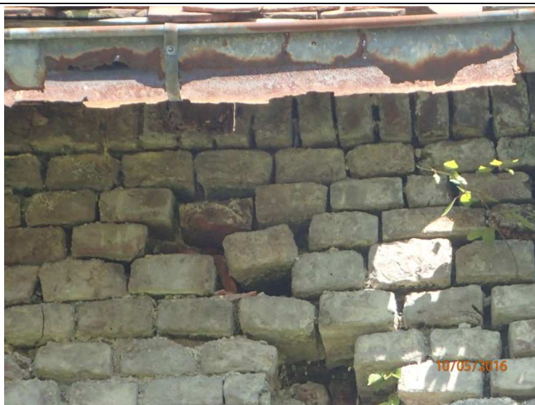
Fot. Z1-23. Znaczne zniszczenia korony murów i skorodowane rynny od strony zachodniej w części „B”
