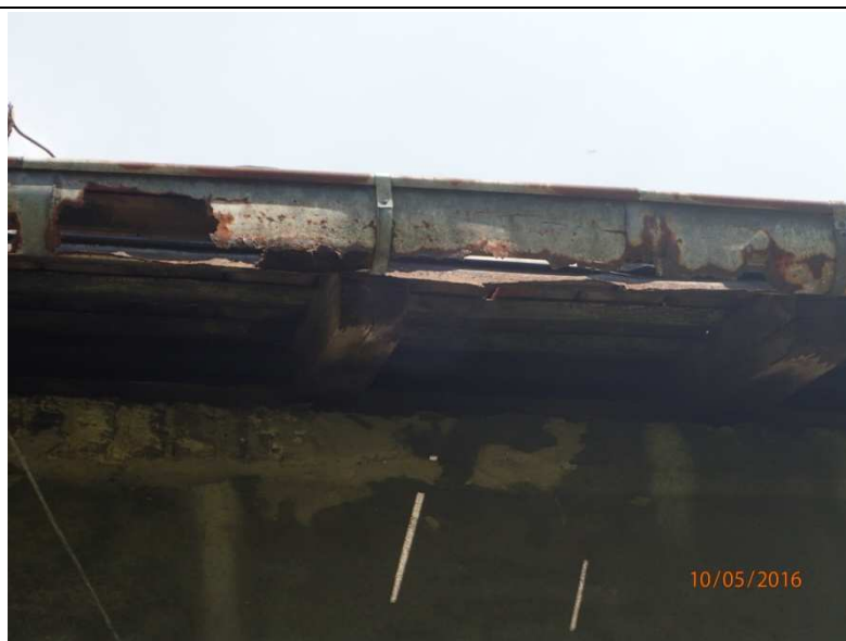
Fot. Z1-31. Skorodowane rynny od strony północnej w części „A”
