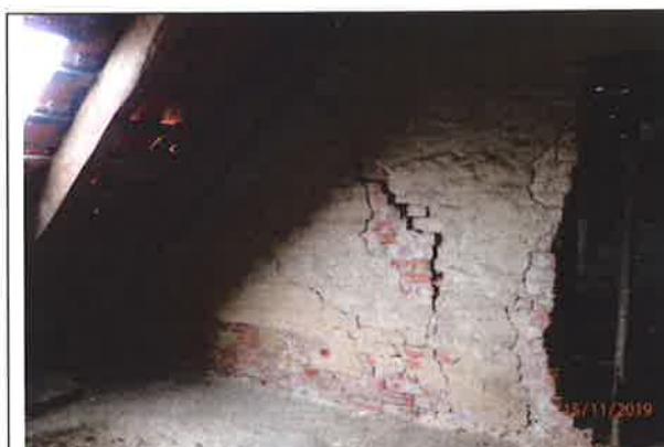
Fot. 24. Pęknięta ściana ogniowa na poddaszu
