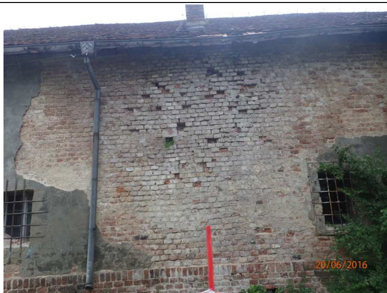
Fot. Z1-13. Znaczny obszar degradacji technicznej powierzchni murów ściany zachodniej
