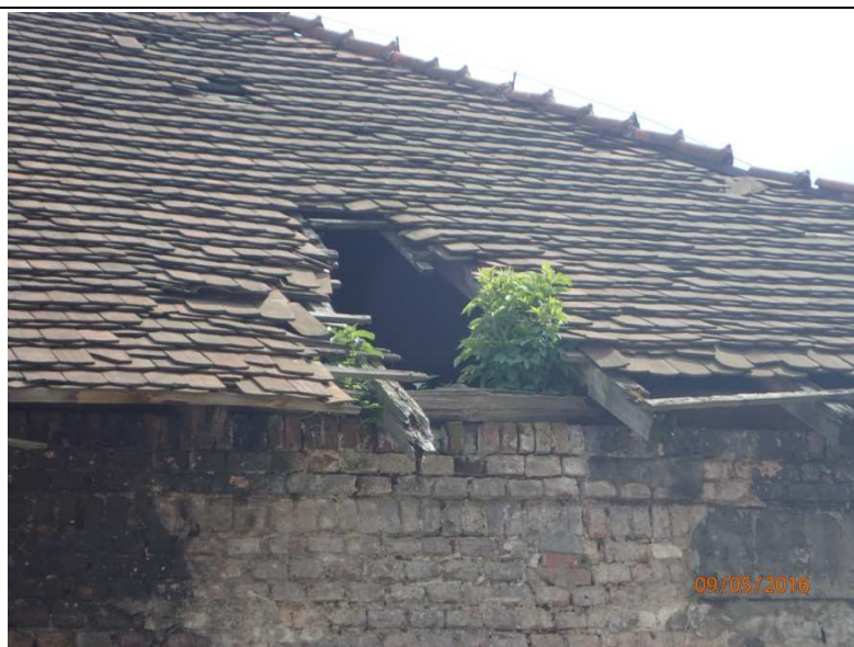
Fot. Z1-34. Zniszczony fragment dachu wraz z jego konstrukcją
