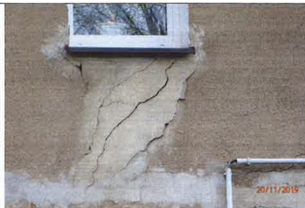
Fot. 17. Pęknięcia ściany nad wejściem do budynku
