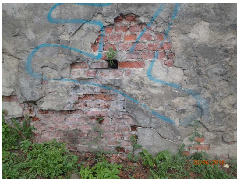
Fot. Z1-18. Fragment cokołu ściany zachodniej – widoczny zakres degradacji technicznej
