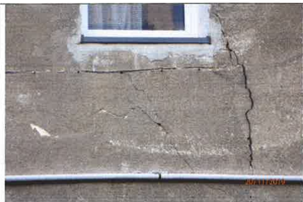
Fot. 19. Pęknięcia w rejonie podparapetowym
