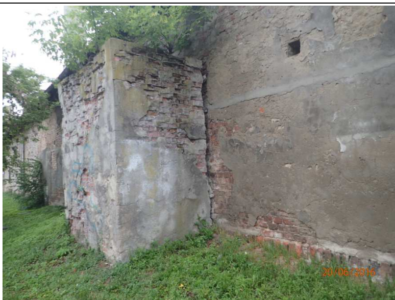
Fot. Z1-15. Stan techniczny dobudówki do części „B” – widoczne znaczne porosty roślinne
