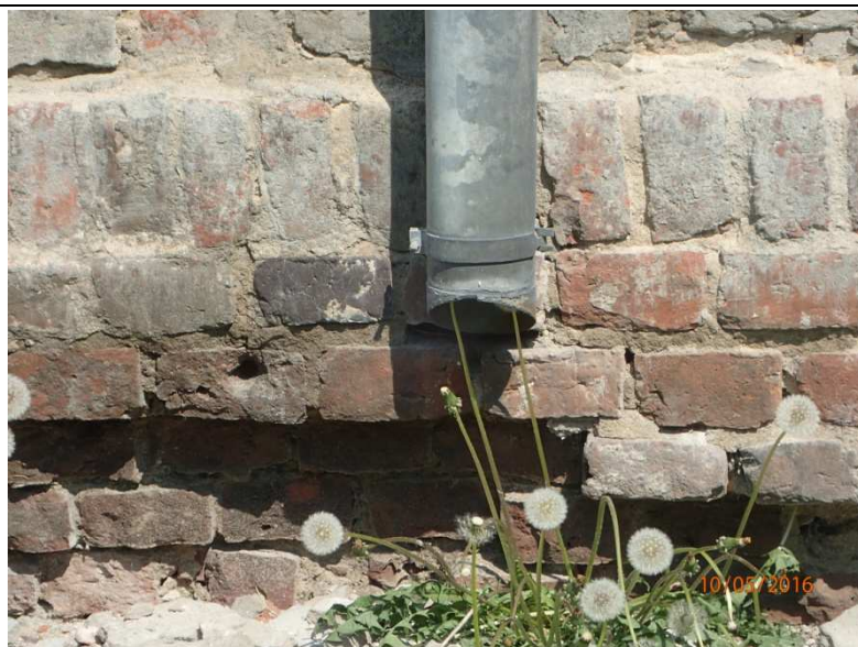
Fot. Z1-22. Zakończenie rury spustowej odprowadzającej wody opadowe na teren i zdegradowany fragment cokołu
