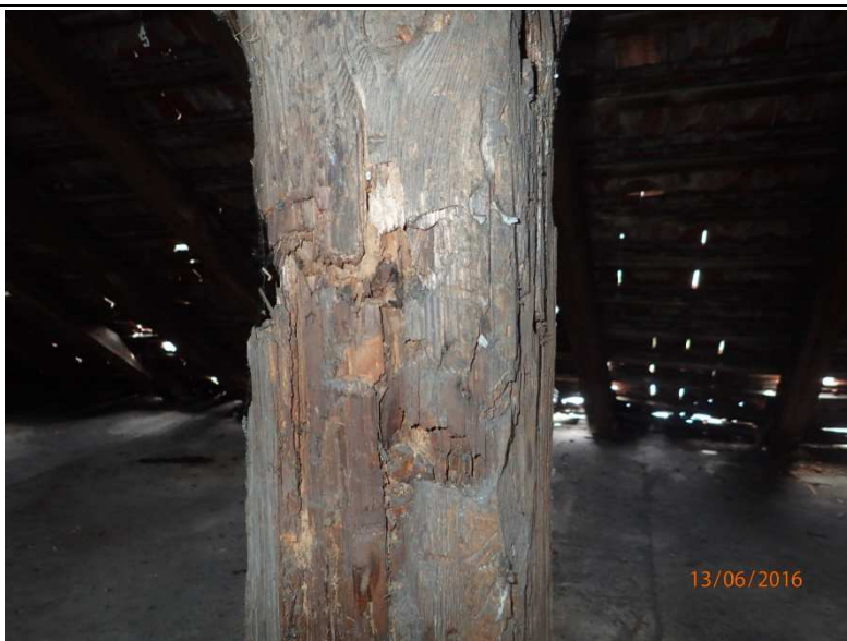
Fot. Z1-55. Ślady porażenia owadami słupa układu nośnego konstrukcji dachu w części „A”
