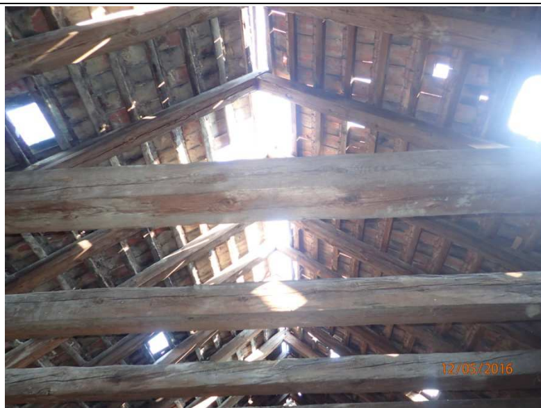
Fot. Z1-58. Widok na kalenicę w części „B” - znaczne ubytki w pokryciu
