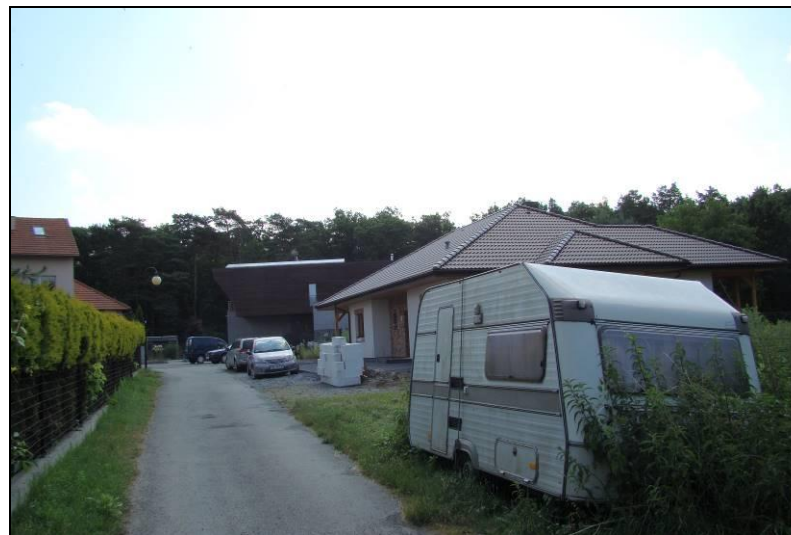
Fot. 11 Ul. Malinowa, zabudowa na północ od terenu 1.5
