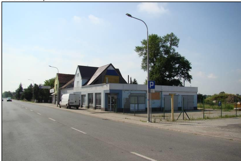
Fot. 6 Teren 1.3, widok w kierunku południowym
