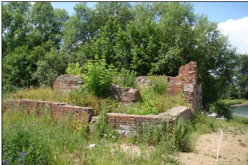
Fot. 17 Teren nr 1.6, pozostałości dawnej budowli hydrotechnicznej, prawdopodobnie elektrowni wodnej
