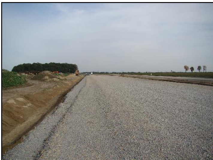
Fot. 6 Nowo budowana północna obwodnica Kędzierzyna-Koźła, widok w kierunku wschodnim
