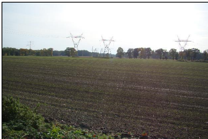
Fot. 28 Widok z DW426 w kierunku południowo-wschodnim
