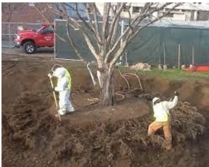
Ryc. 13. Zastosowanie bariery korzeniowej
