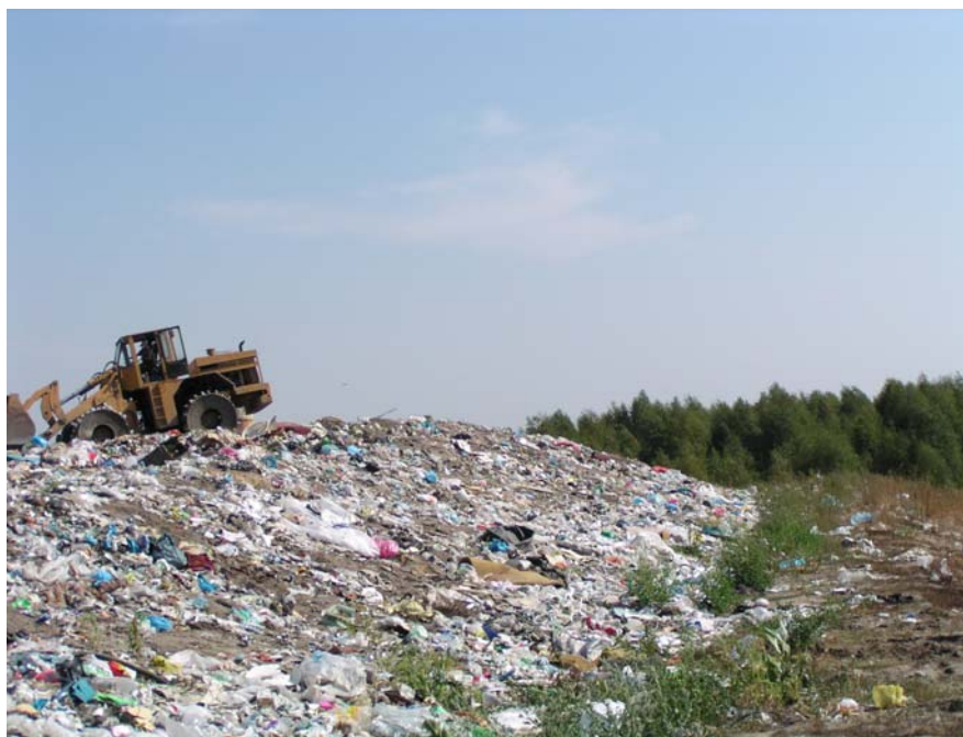
Fotografia 7. Miejskie Składowisko Odpadów w Sławięcicach – budowa drugiej półki kwatery do rzędnej 210 m n.p.m. (etap przed rekultywacją skarpy)
