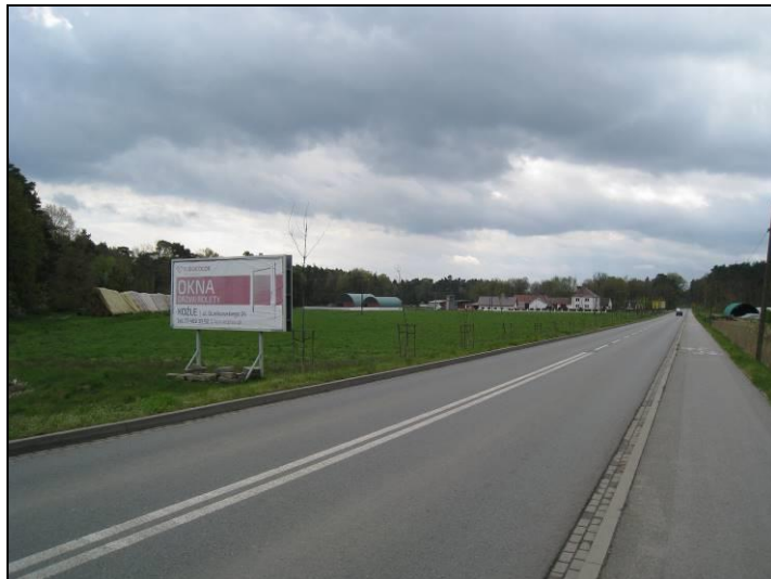
Fot. 17 Teren nr 1.4, widok z ul. J. Brzechwy od strony wschodniej
