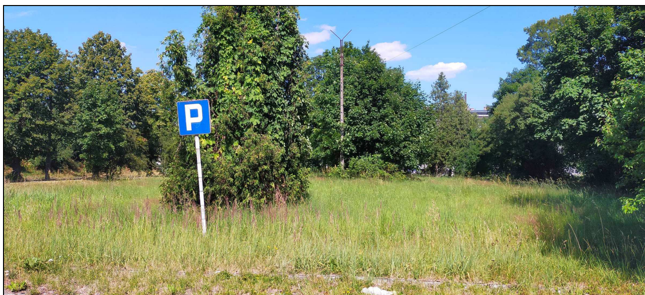
Fot.1 Po środku zdjęcia widoczny jest betonowy słup po nieczynnej latarni oświetleniowej przeznaczony do osłonięcia pnączem. Widoczna jest zawieszona na nim przewieszka teletechniczna (źródło: inwentaryzacja 11-07-2023r.).
