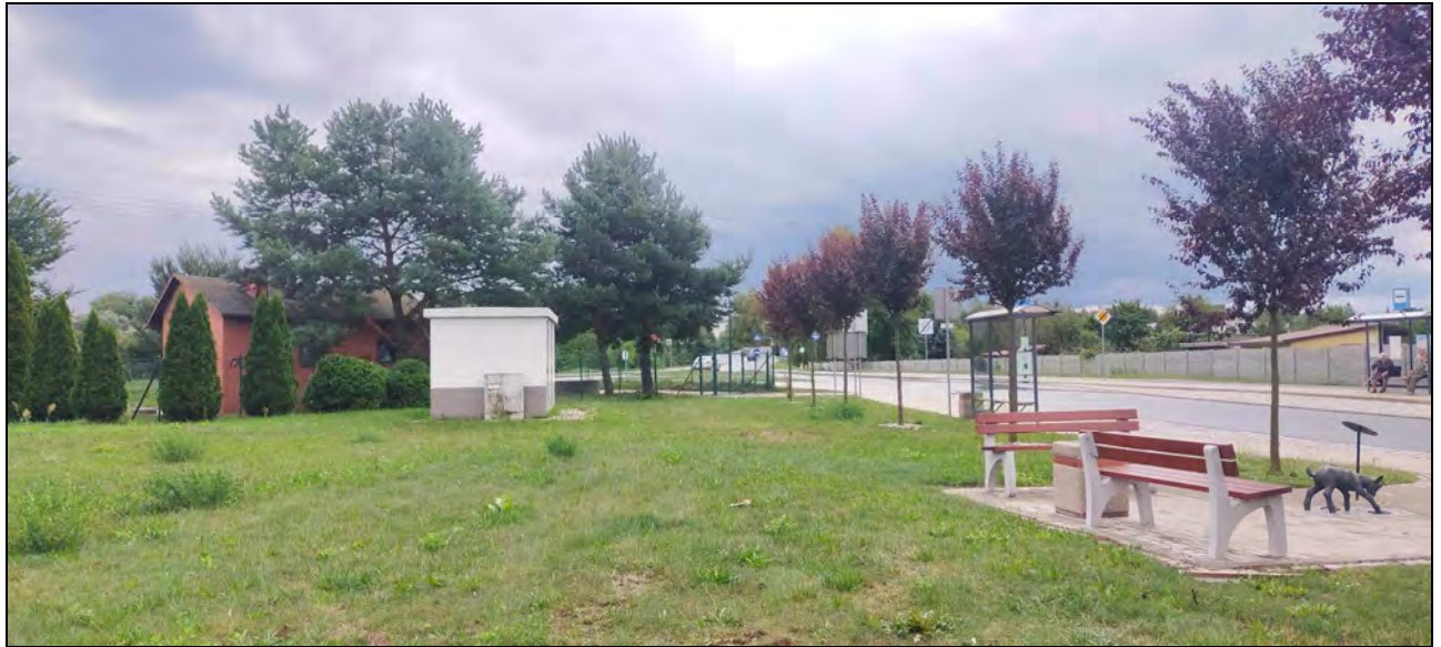
Fot.2 Widok z samego skwerku - od strony ławek i „kozyłka” w kierunku stacji transformatorowej. Po prawej widoczne są ławki, kosz na śmieci i rzeźba kozyłka a po lewej stacja transformatorowa (za nią - w tle - budynek przepompowni ścieków (źródło: inwentaryzacja 31-08-2023r.).
