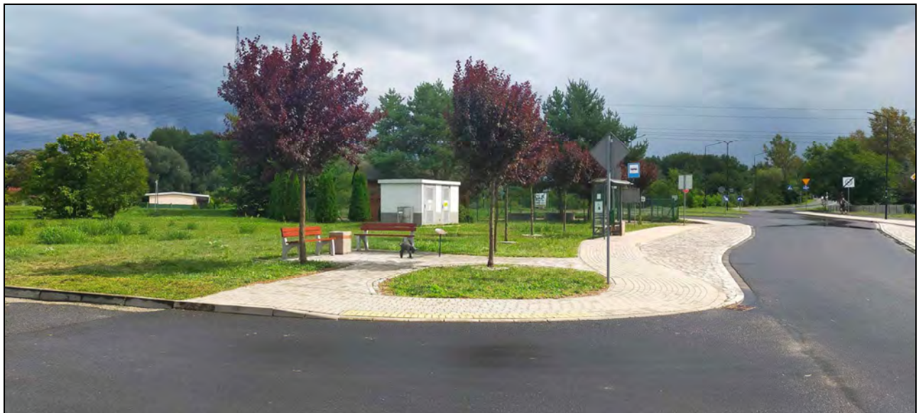
Fot.1 Widok ze skrzyżowania ul. Ogrodowej i al. Spokojnej w kierunku skweru. Na pierwszym planie widoczne są ławki, kosz na śmieci i rzeźba koziołka a w tle stacja transformatorowa (źródło: inwentaryzacja 31-08-2023r.).
