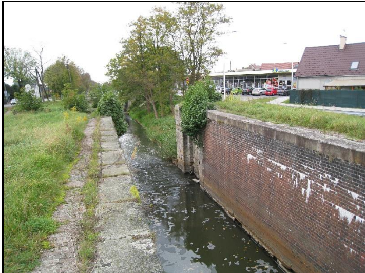
Fot. 6 Śluza na Kanale Kłodnickim w rejonie ul. Kłodnickiej
