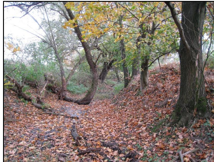
Fot. 19 Wnętrze dawnego kanału
