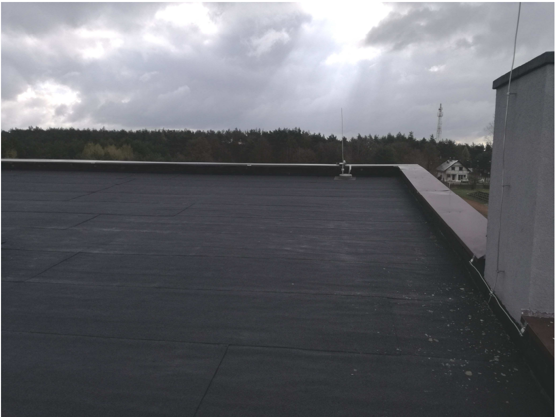
fot. nr 6 Widok połaci dachu objętej opracowaniem
