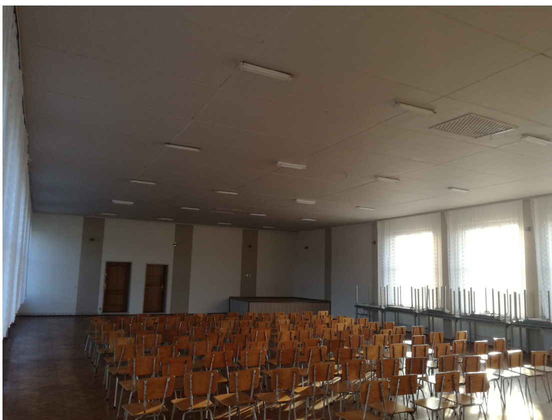
fot. nr 11 Widok sufitu podwieszanego do kratownic i krawędziaków pośrednich
