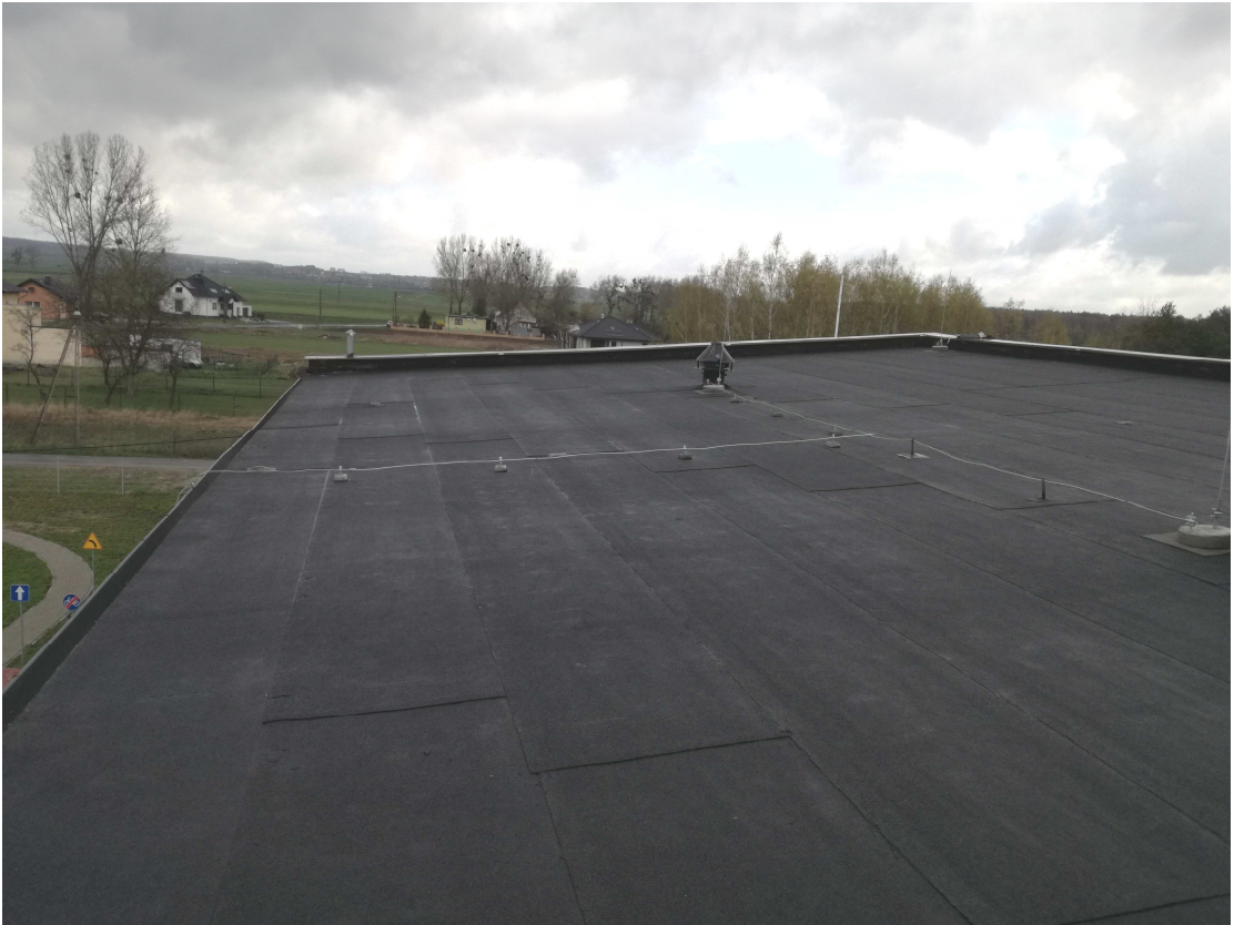
fot. nr 5 Widok połaci dachu objętej opracowaniem
