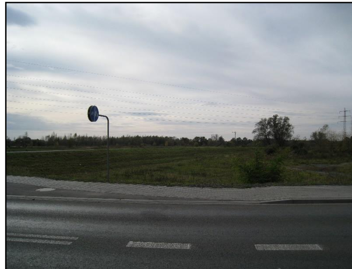
Fot. 49 Wał przeciwpowodziowy (poza zachodnią granicą analizowanego terenu)
