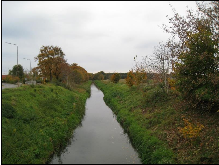
Fot. 1 Kanał Kłodnicki w kierunku wschodnim z mostu na ul. I. Krasickiego
