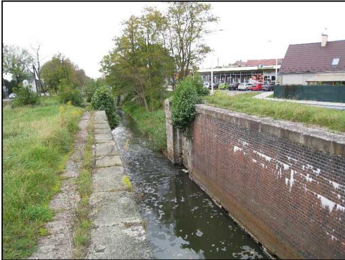
Fot. 13 Śluza na Kanale Kłodnickim w rejonie ul. Kłodnickiej
