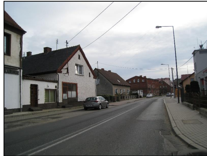
Fot. 30 Ul. Kłodnicka, widok w kierunku południowym
