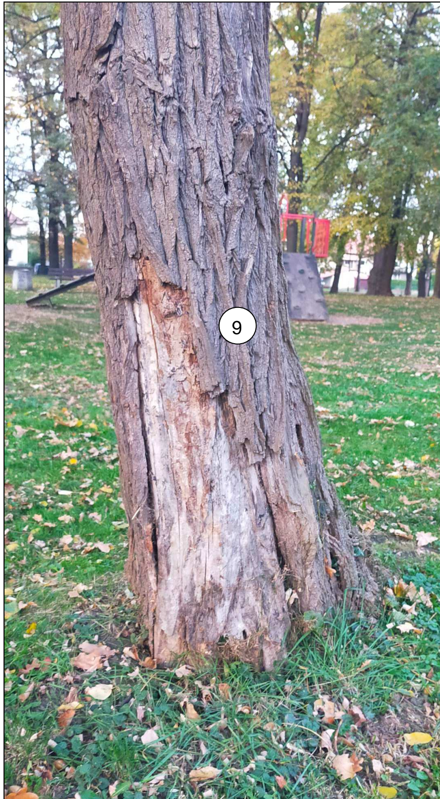
Fot.5 Drzewo nr 9 i duża martwica robinii przy odziomku - konieczna jest dalsza regularna obserwacja tego egzemplarza.
