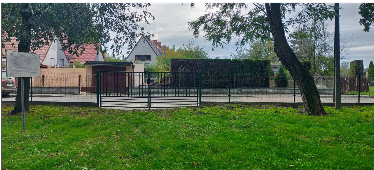
Fot.2 Brama wjazdowa na teren inwestycji od strony ulicy Filtrowej (źródło: inwentaryzacja 10-10-2024r.).
