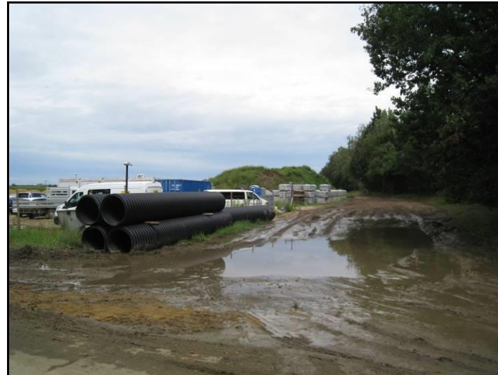
Fot. 12 Nowo budowany łącznik DK40 z ul. Przyjaźni w rejonie ul. Szpaków
