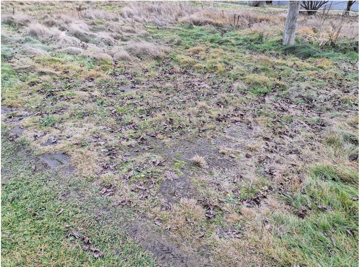
Zdj.12 – Fundament znajdujący się na działce 1008/20 częściowo wchodzący w pas drogowy
