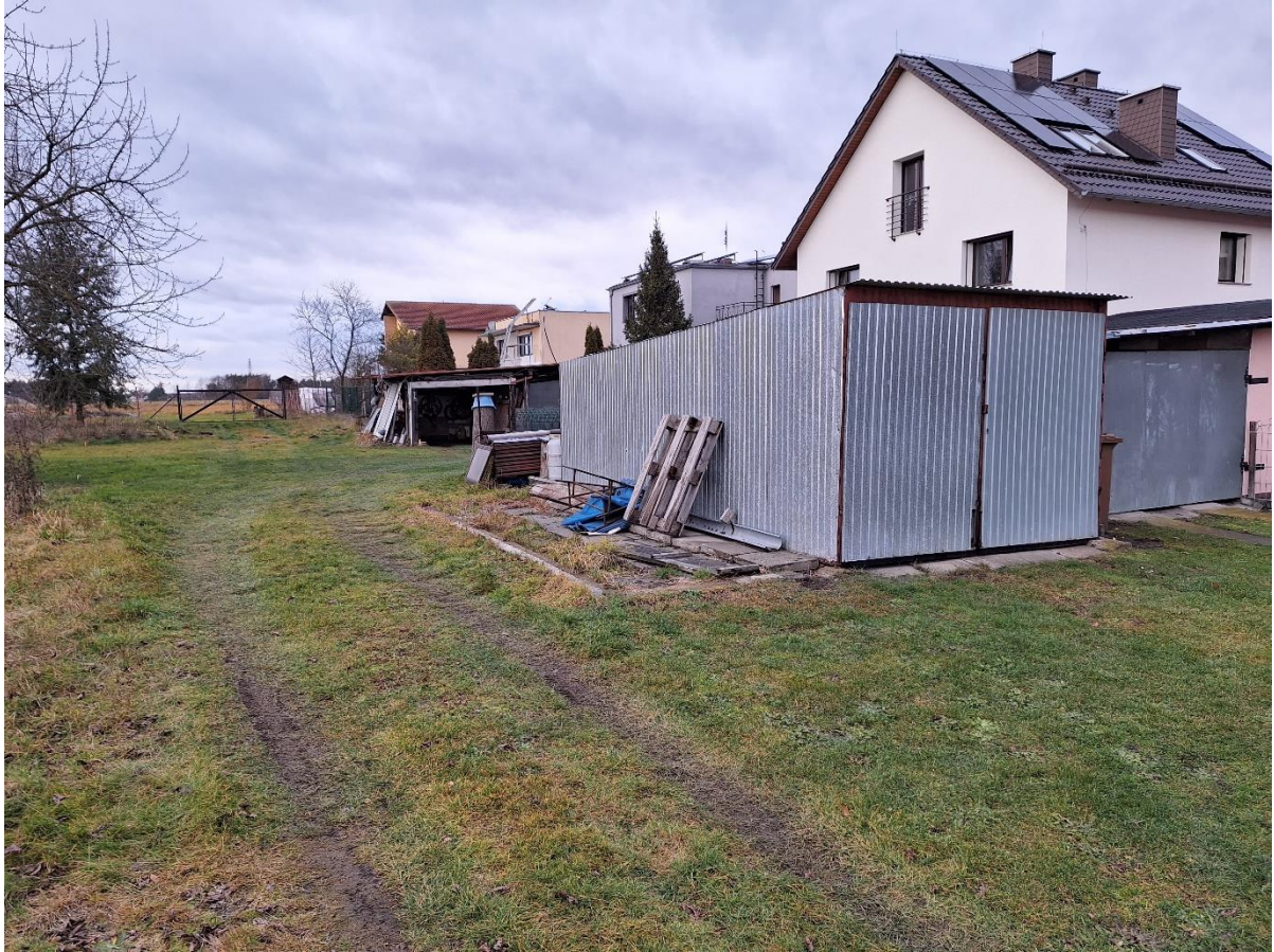
Zdj.4 – Fundament przeznaczony do rozbiórki przy działce 1008/5
