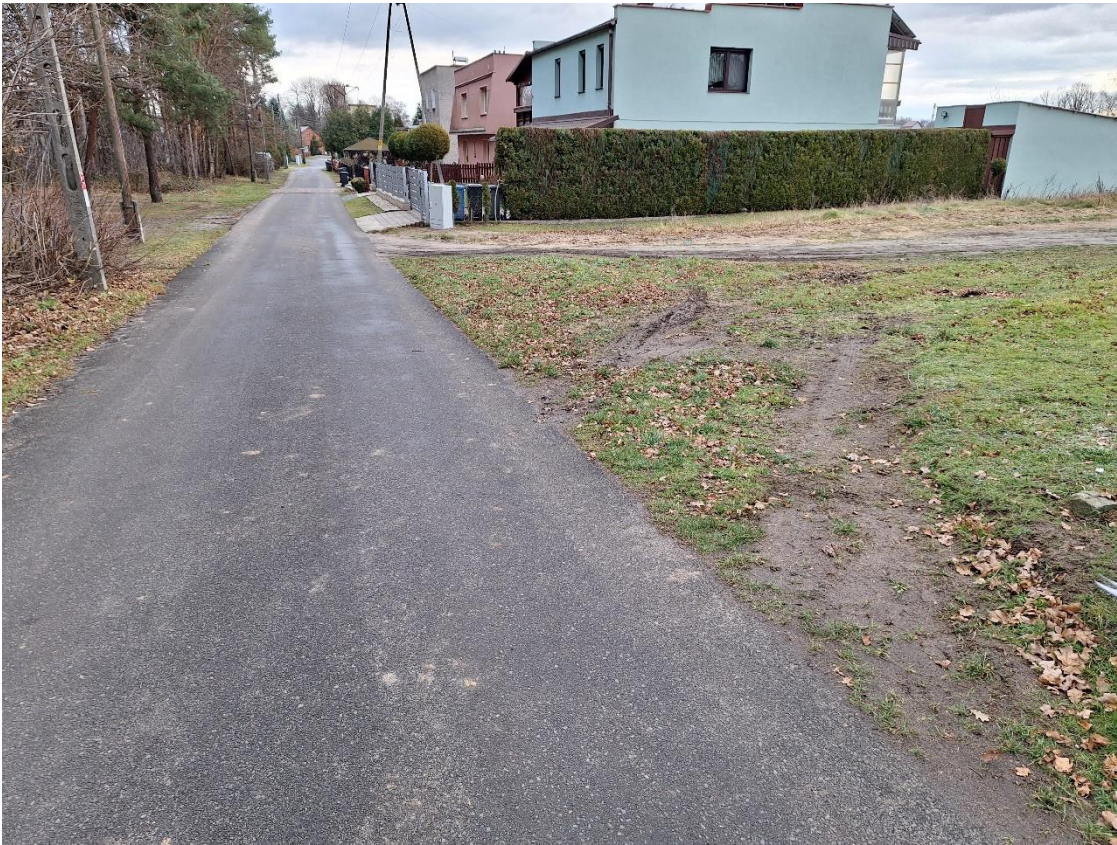
Zdj.1 – Miejsce włączenia projektowanej drogi gminnej do istniejącej ul. Czyżyków
