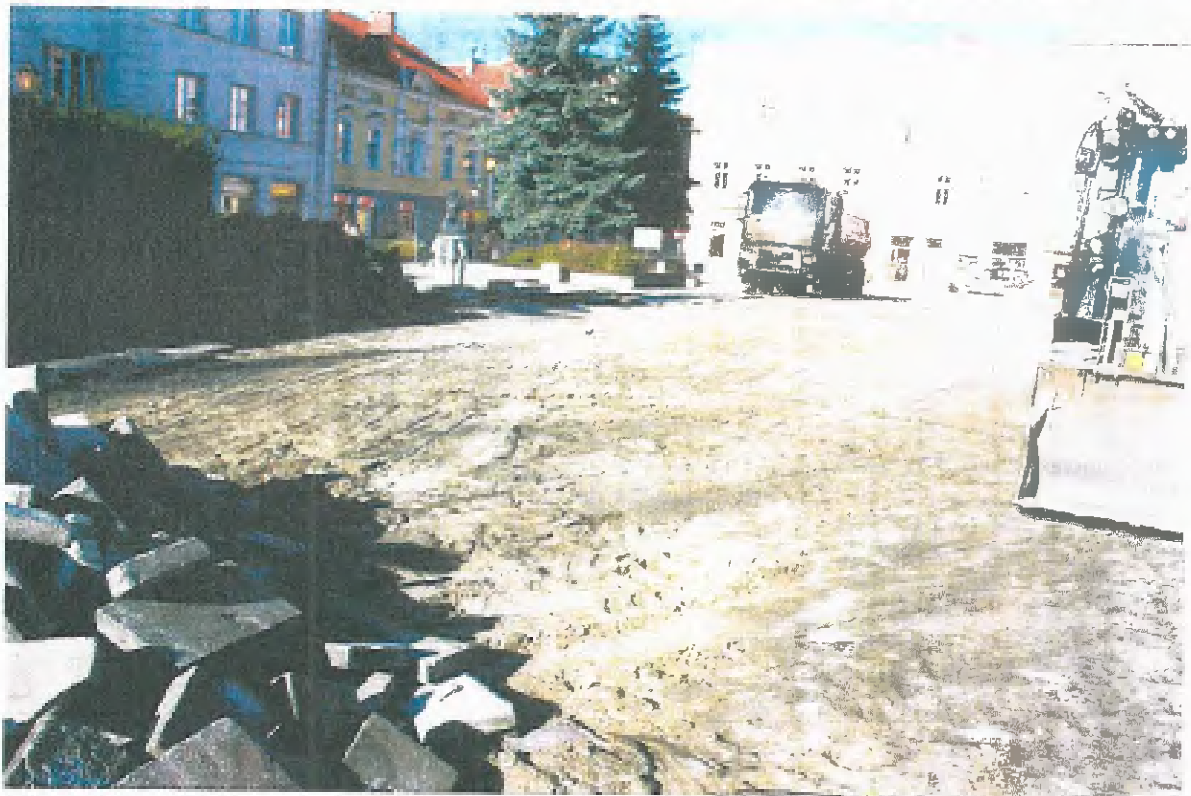
Ryc. 2-3. Widok rozebranej nawierzchni rynku w Koźlu. Fot.
