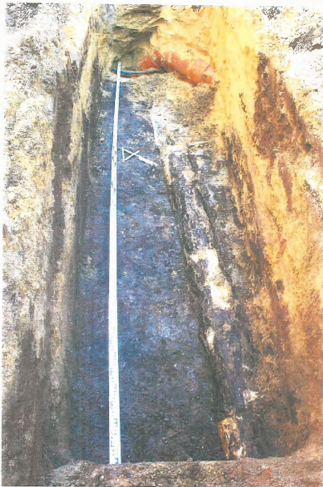
Ryc. 31. Widok wodociągu drewnianego w wykopie kan deszczowej. Fot.
