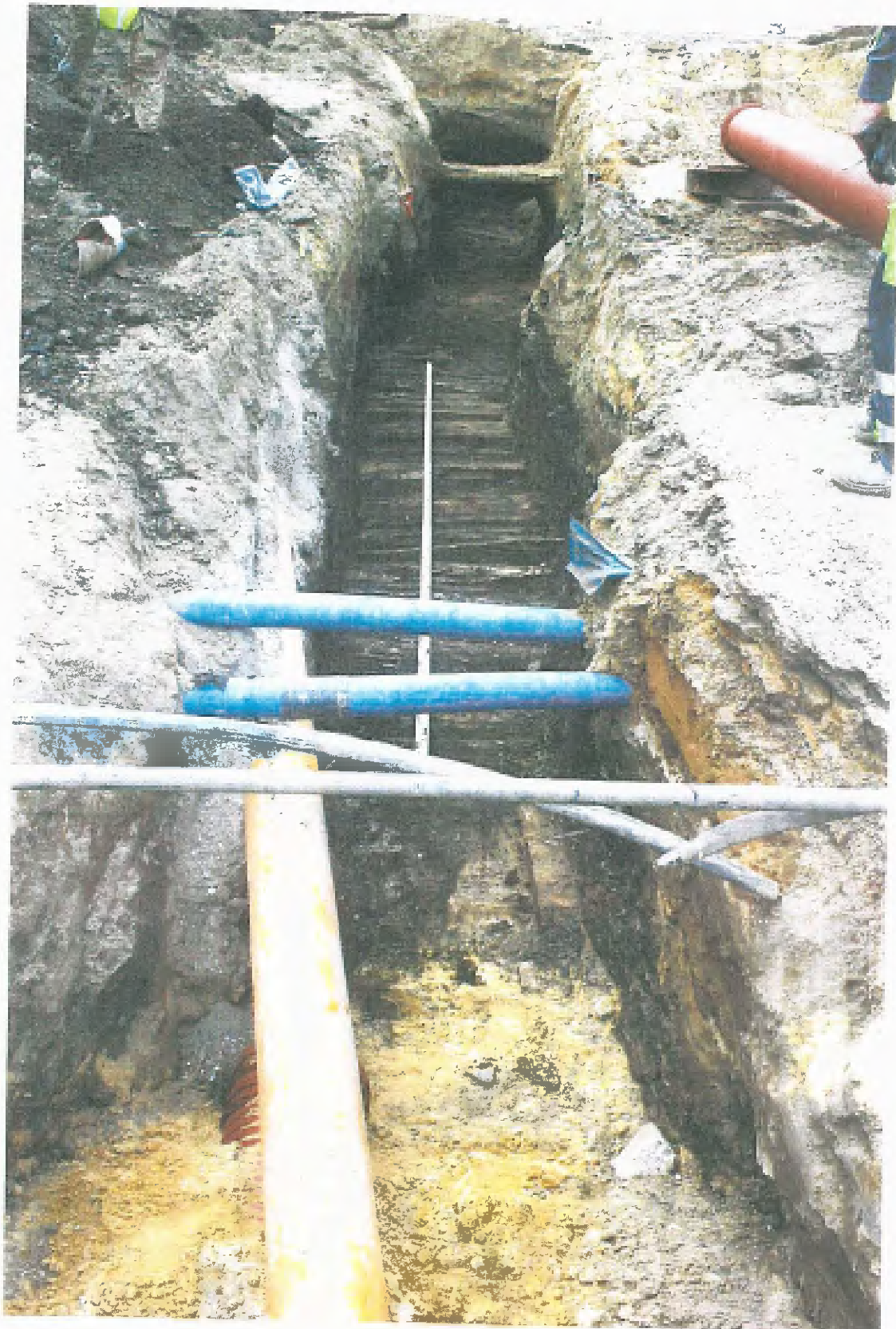
Ryc. 26. Widok nawierzchni drogi drewnianej. Fo
